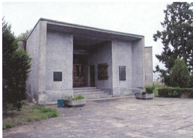
Widok na istniejący budynek muzeum
