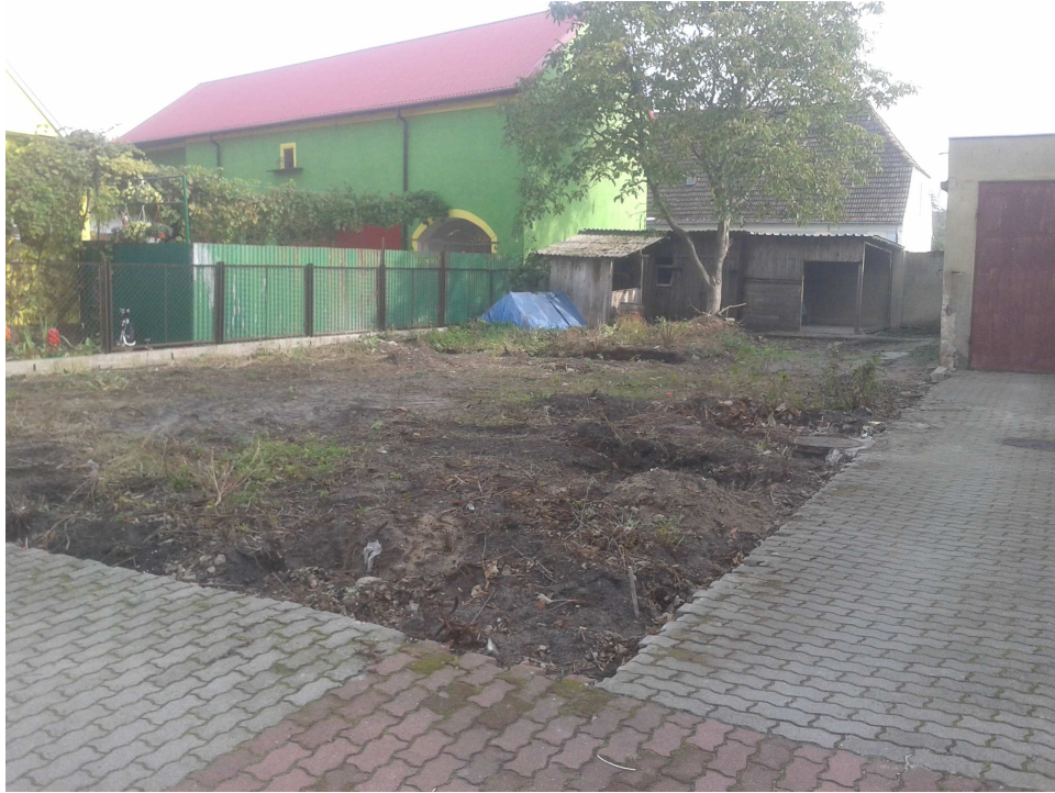
Fot. 5: Teren przyległy do ul. Sikorskiego na dz. ewid. nr 1707 i 1708 (utwardzenie terenu 4)
