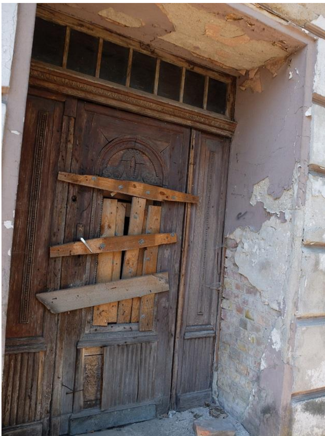
Drzwi w wejściu do kamienicy – obecny stan zachowania
