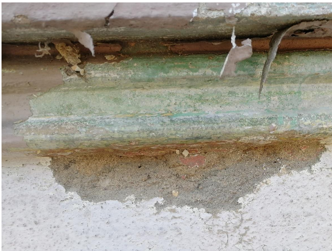
Fragmenty elewacji frontowej – widoczne pierwotne warstwy malarskie w kolorze czerwonym (lico elewacji) i zielonym (parapet okna) odstąpione spod wtórnych
