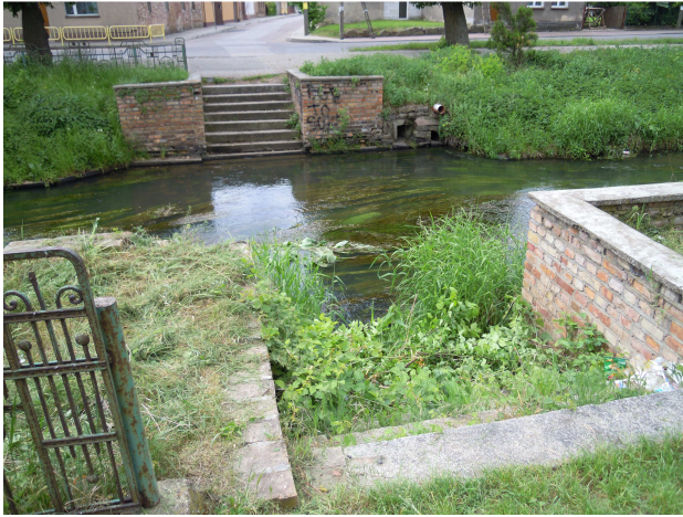
Widok na murowane zejścia do rzeki
