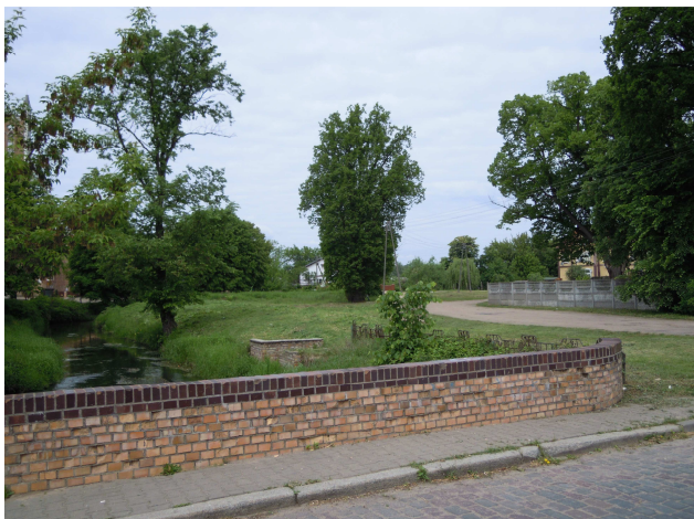
Widok na teren od strony wschodniej (z mostu „A”)
