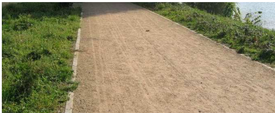
Nawierzchnia z kruszywa mineralnego
