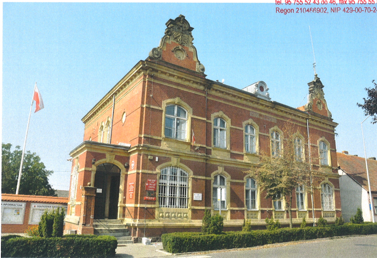
Fot. 3. Elewacja wschodnia - frontowa- obiektu, obecny stan zachowania.
