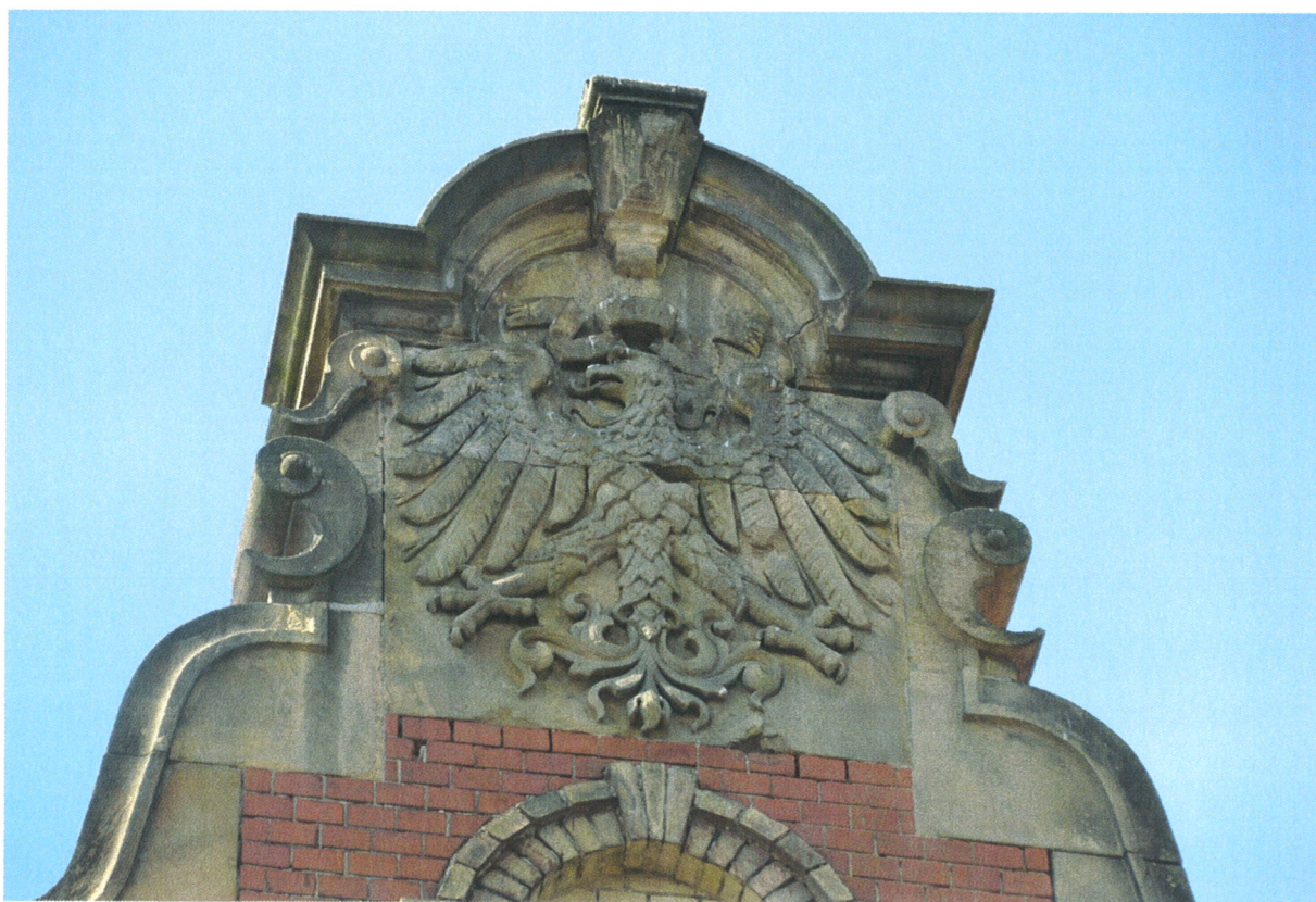
Fot. 4. Płaskorzeźba orła w obrębie lewego szczytu elewacji frontowej obiektu- obecny stan zachowania. Na powierzchni korony inskrypcja – Erbau.
