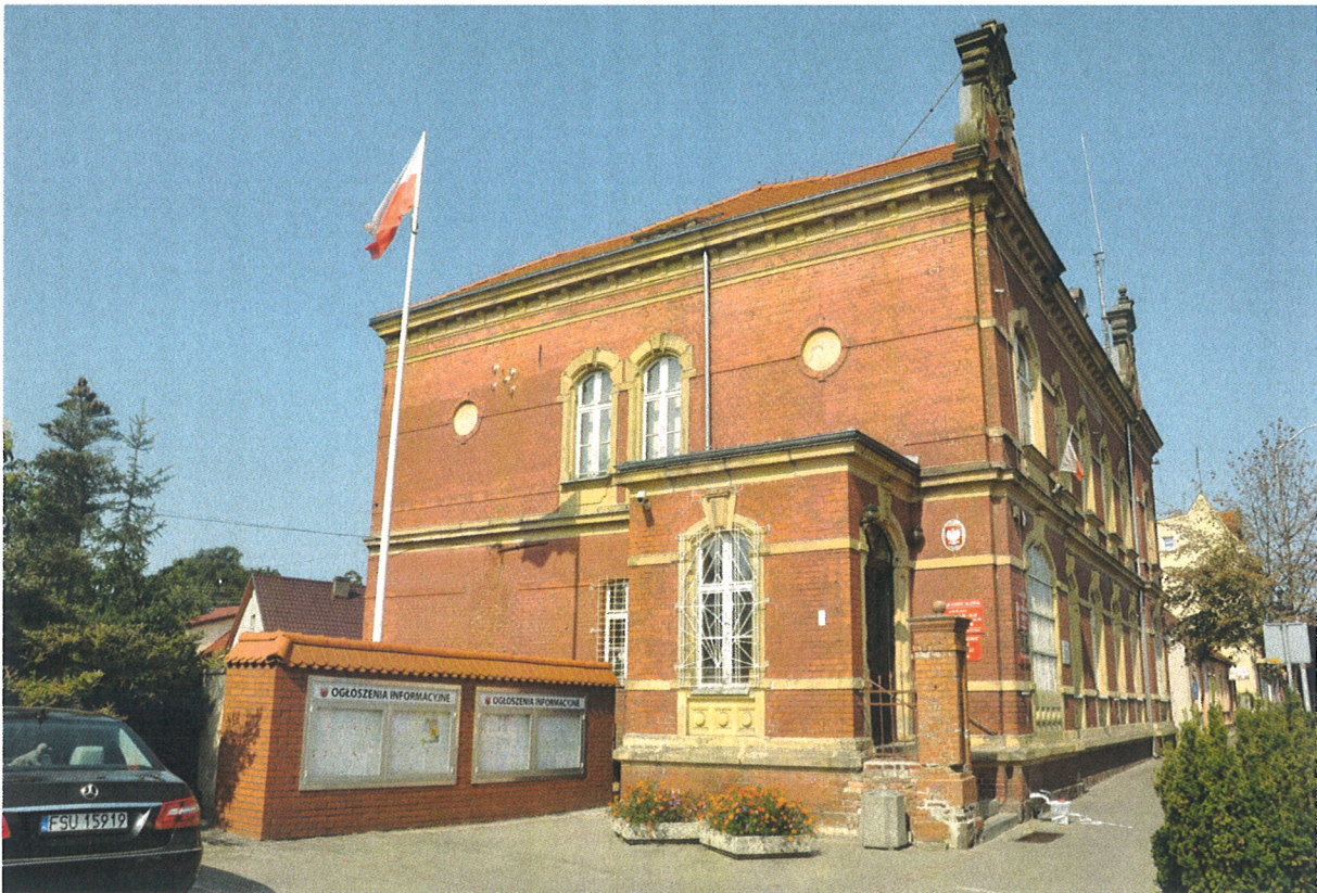
Fot. 22. Elewacja południowa wraz z przedsionkiem - obecny stan zachowania.
