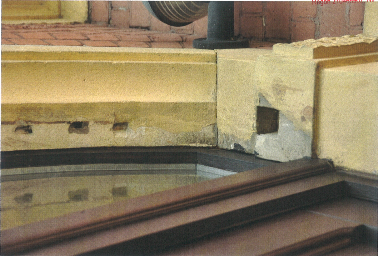
Fot. 29. Obramienie głównego wejścia do obiektu. Widoczne m.in. gniazda pierwotnej konstrukcji stolarki drzwiowej obiektu.
