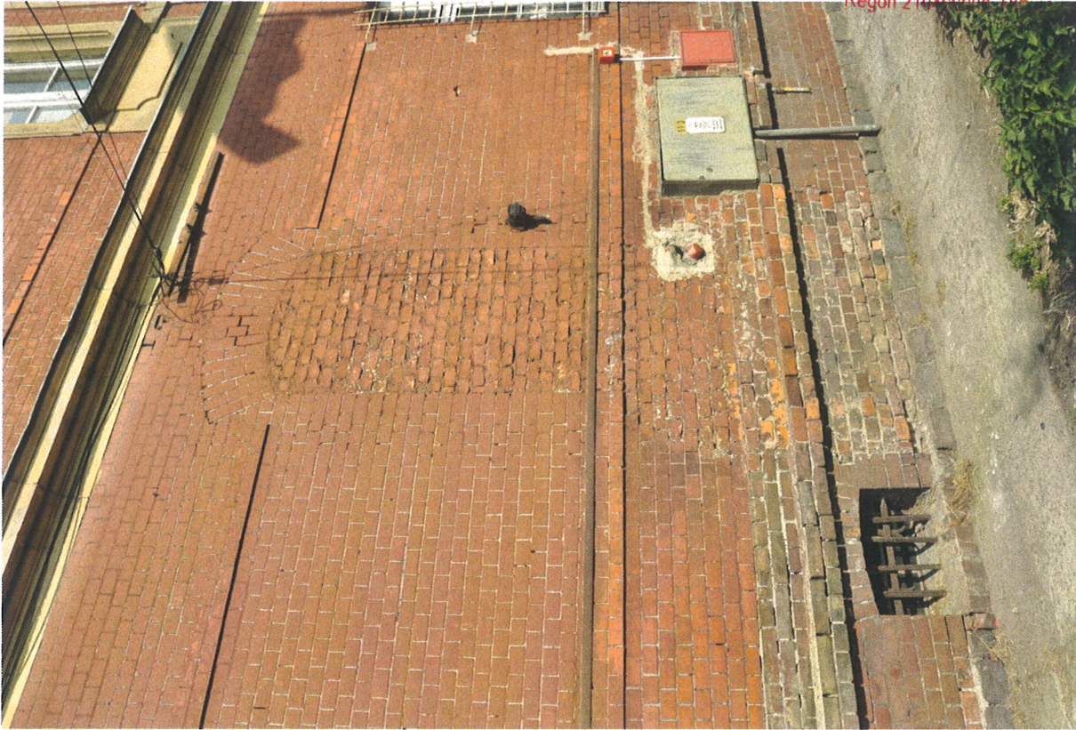
Fot. 21. Fragment elewacji południowej budynku - obecny stan zachowania. Widoczne m. in. przemalowania ceglanego lica muru, wtórne zamurowanie otworu okiennego, przekształcenia w obrębie strefy cokołowej (w tym obecność elementów instalacji elektrycznej).
