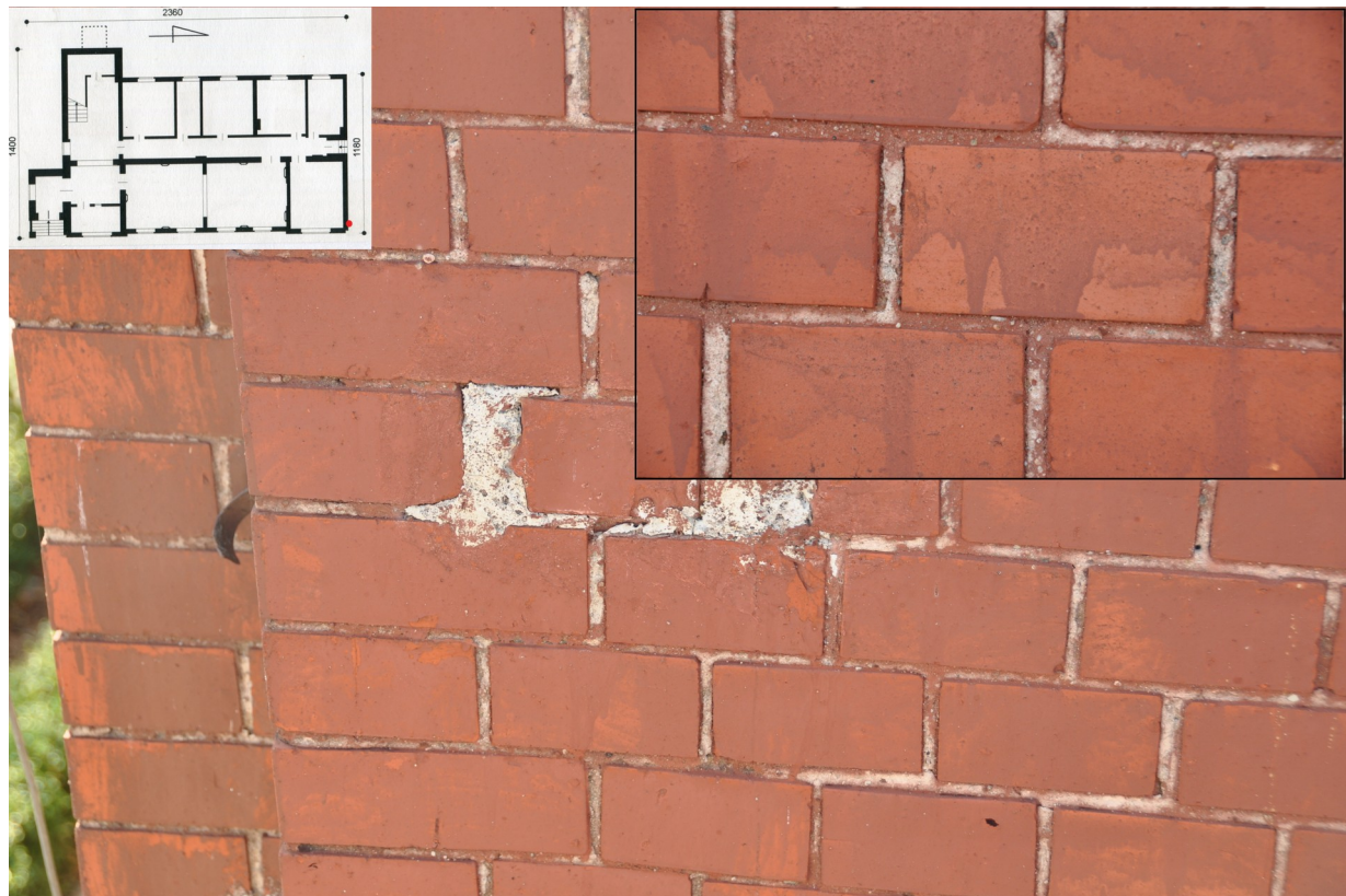
Fot. 16. Fragment elewacji północnej z widocznymi śladami wtórnych powłok malarskich pokrywających powierzchnię ceglanego lica obiektu.
