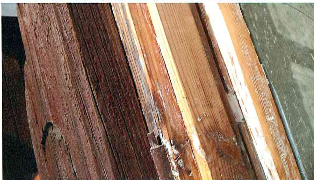
Spękania drewnianej lizeny i elementu ozdobnego lukarny w postaci ślimacznicy
