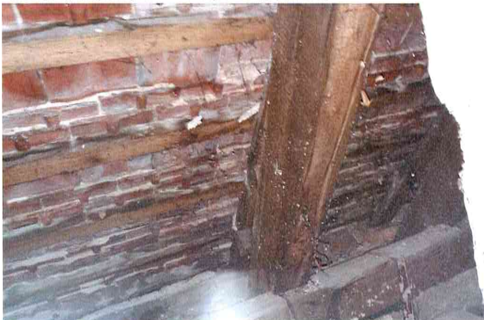
Wewnętrzny fragment połaci dachowej od strony północnej
