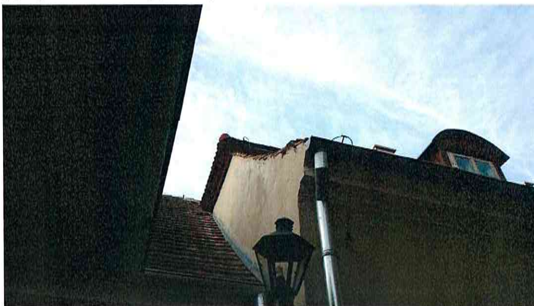
Dach łącznika głównego budynku muzeum z dawną oficyną, orynnowanie, instalacja odgromowa gzymsy i lukarna od strony północnej
