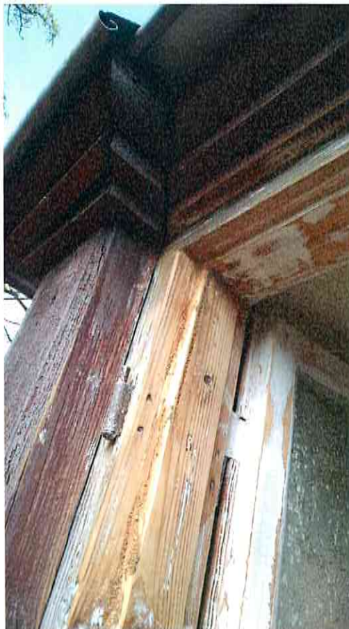
Spękania drewnianej lizeny i elementu ozdobnego lukarny w postaci ślimacznicy
