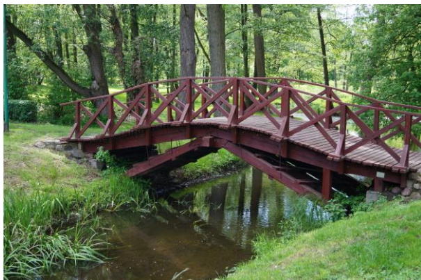
Zdj. Nr 11 Zbliżenie mostku – kładki pieszej – stan istniejący
