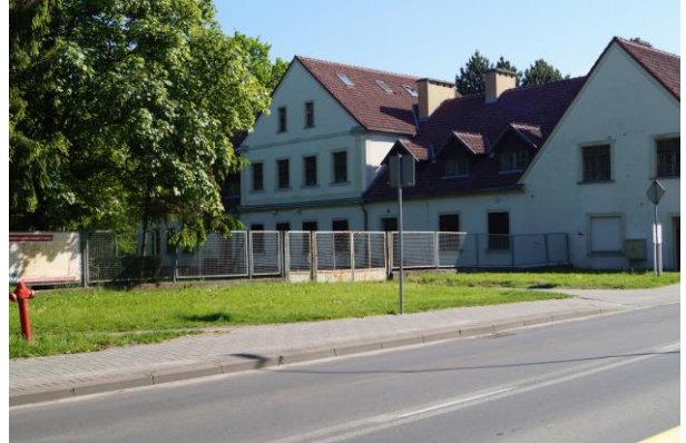
Zdj. Nr 10 Miejsce wjazdu na parking i drogę ppoż., wejście dla pieszych (strefa wejściowa ul. Zachodnia) – droga wojewódzka nr 137 – stan istniejący
