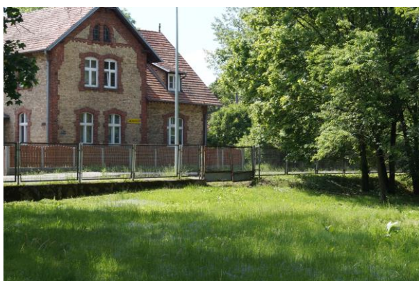
Zdj. Nr 19 Widok na ogrodzenie i bramę wjazdową od strony parku (teren przyszłego parkingu) – stan istniejący
