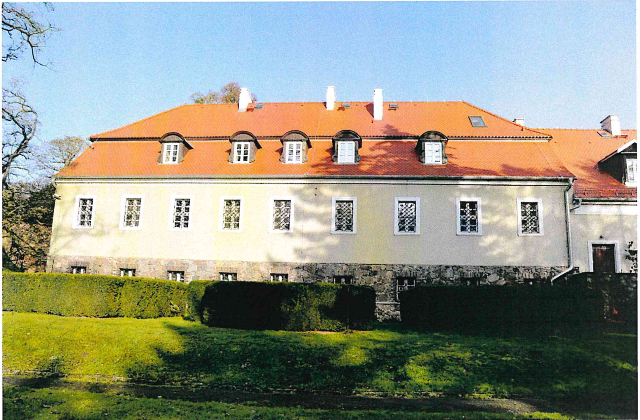
Fot. 5. Elewacja południowa, aktualny stan zachowania
