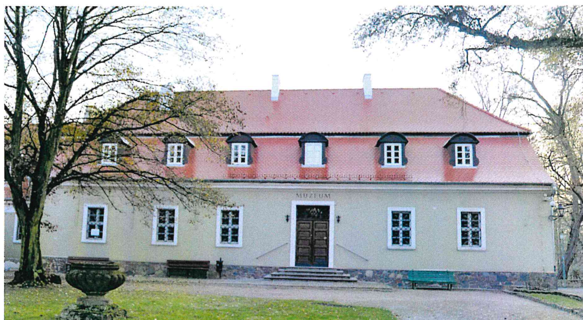
Fot. 4. Elewacja frontowa, obecny stan zachowania.
