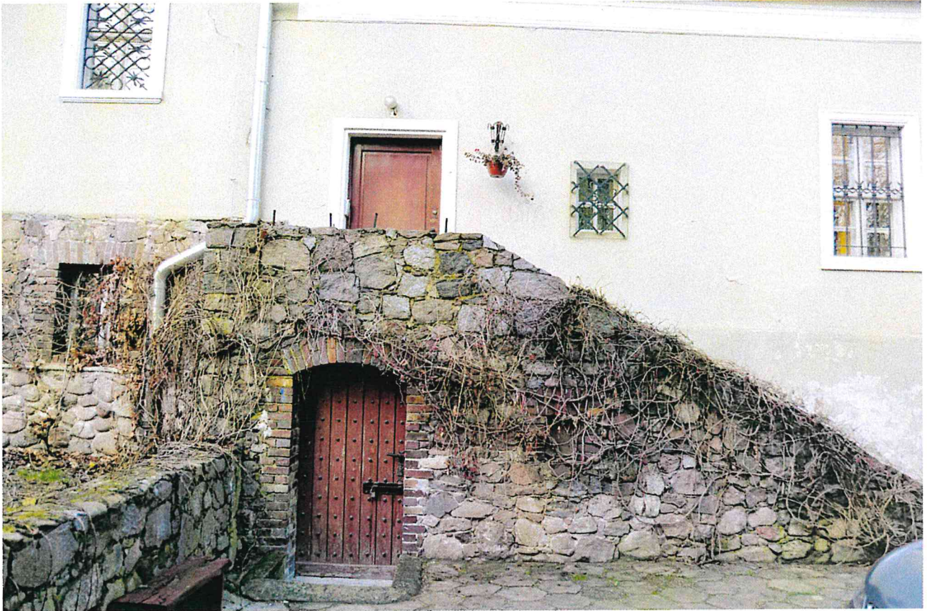
Fot. 13. Klatka schodowa elewacji południowej łącznika, aktualny stan zachowania.
