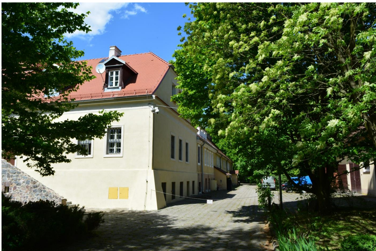
Zdj. Nr 4. Widok na budynek oficyny dworskiej od strony południowej – część A obiektu. Zdjęcie wykonane w 2021 r.
