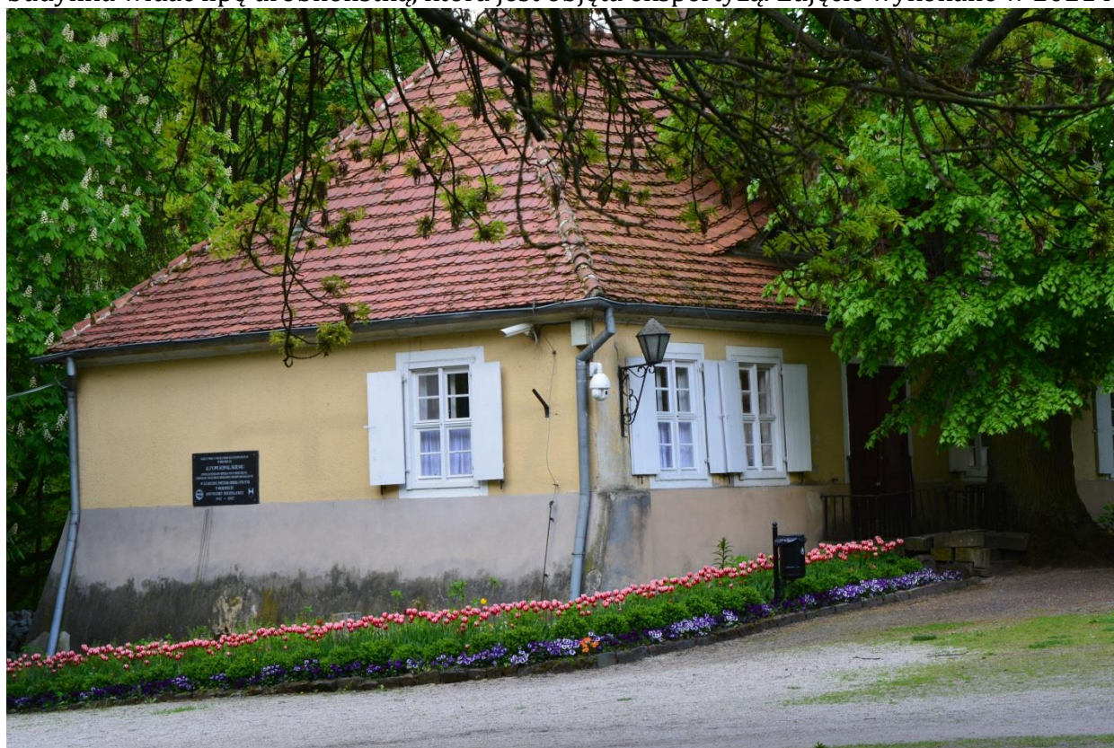
Zdj. Nr 3. Widok na budynek oficyny dworskiej od strony północnej – część B obiektu. Zdjęcie wykonane w 2021 r.
