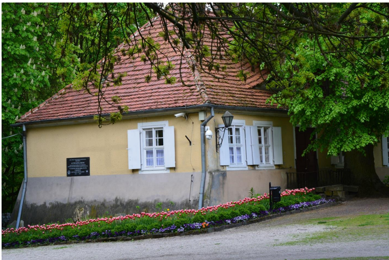
Zdj. Nr 3. Widok na budynek oficyny dworskiej od strony północnej – część B obiektu. Zdjęcie wykonane w 2021 r.
