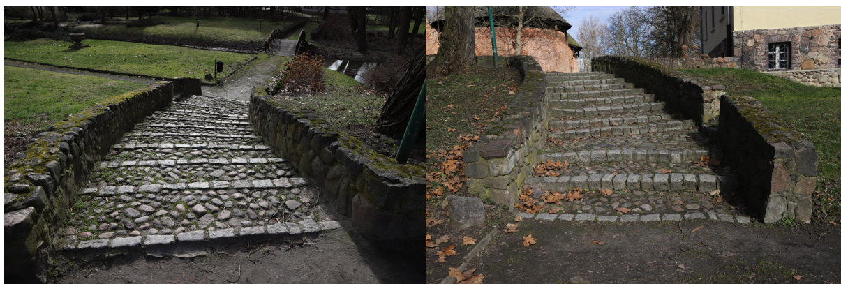
4. Widok na istniejące obecnie schody.
