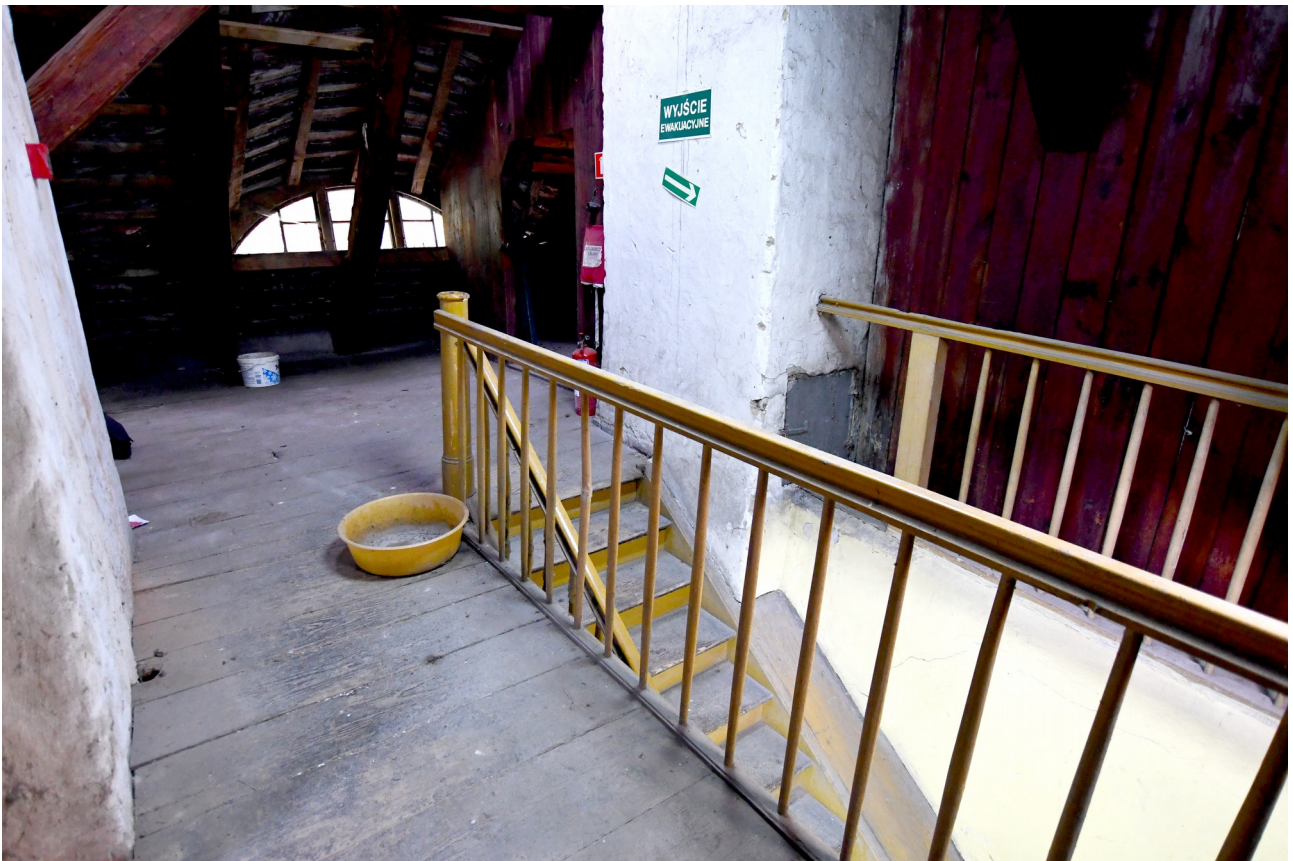
I/5. Oficyna dworu starostów międzyrzeckich część B – poddasze, pom. 1/2, widok od południowego – wschodu, widoczne wyjście schodów K1 oraz powiekowa lukarna połaciowa z fazy III
