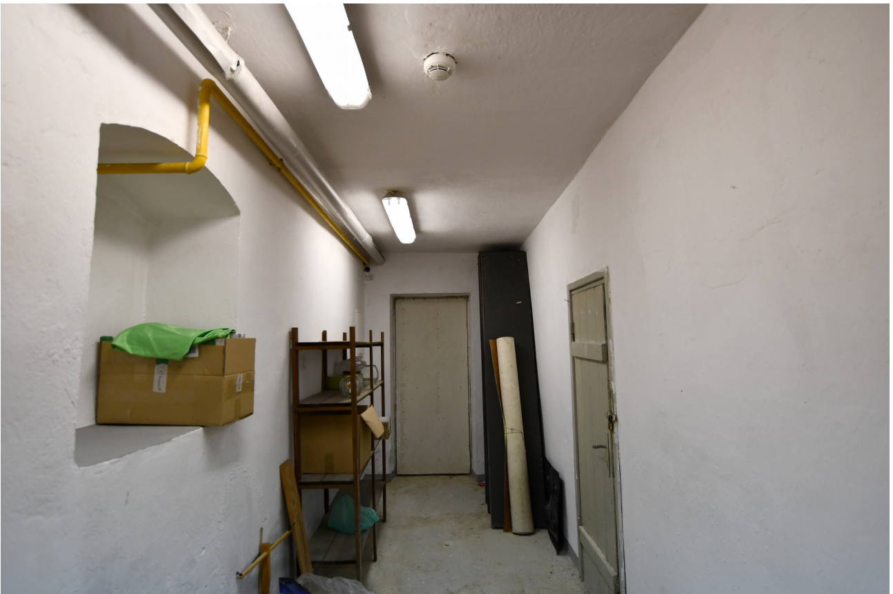
I/16. Oficyna dworu starostów międzyrzeckich część A2 – piwnica, pom. 01/13, widok od południa, w ścianie widoczna, odcinkowo zwieńczona wnęka gospodarcza z fazy II
