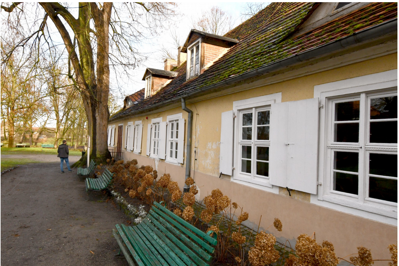
I/4. Oficyna dworu starostów międzyrzeckich część B – elewacja północno – zachodnia, widok od południowego – zachodu
