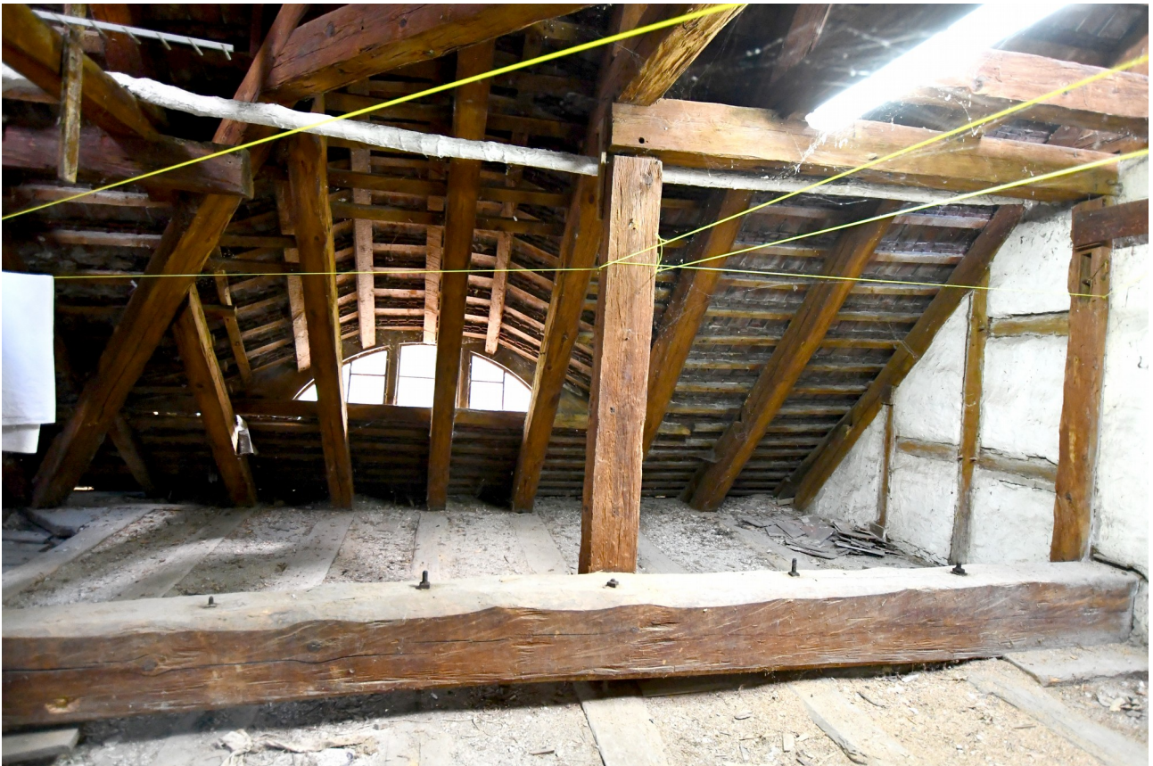
I/7. Oficyna dworu starostów międzyrzeckich część B – poddasze, pom. 1/3, widok od południowego – wschodu, widoczne, odsłonięte belki stropowe, wzmocnione belką nadciągu, konstrukcja więźby dachowej z fazy IB, lukarny powiekowej z fazy II oraz szachulcowa ścianka działowa z fazy III, oddzielająca pom. 1/4
