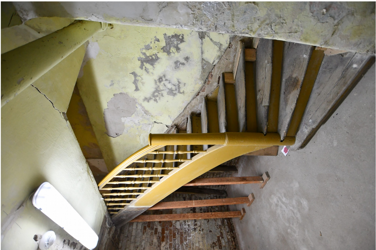
I/13. Oficyna dworu starostów międzyrzeckich część B – piwnica, pomieszczenie klatki schodowej K1, widok ogólny od południa, widoczna podstemplowana konstrukcja drewnianej, zabiegowej klatki schodowej z fazy III
