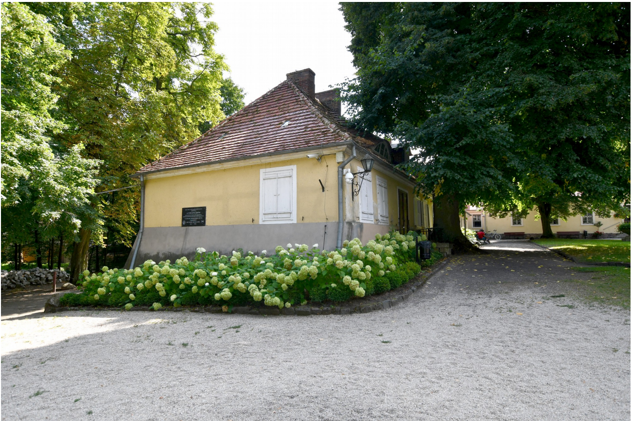
I/3. Oficyna dworu starostów międzyrzeckich część B – elewacja północno – zachodnia, widok ogólny od północnego – zachodu
