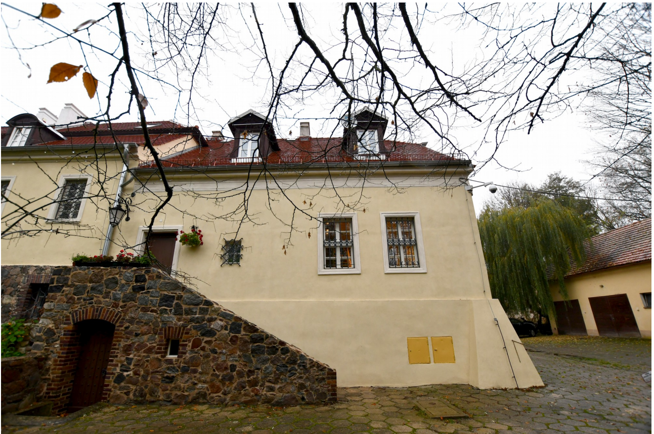
I/2. Oficyna dworu starostów międzyrzeckich część A2 – elewacja południowo – zachodnia, widok ogólny od południowego – zachodu
