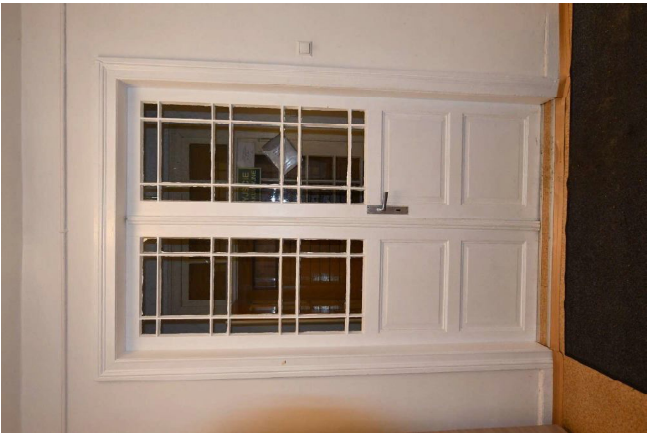
III/15. Oficyna dworu starostów międzyrzeckich, część B, parter, pom. 0/2, dwuskrzydłowa, przeszklona stolarka drzwiowa, widok od wnętrza, 1 poł. XX w., faza III
