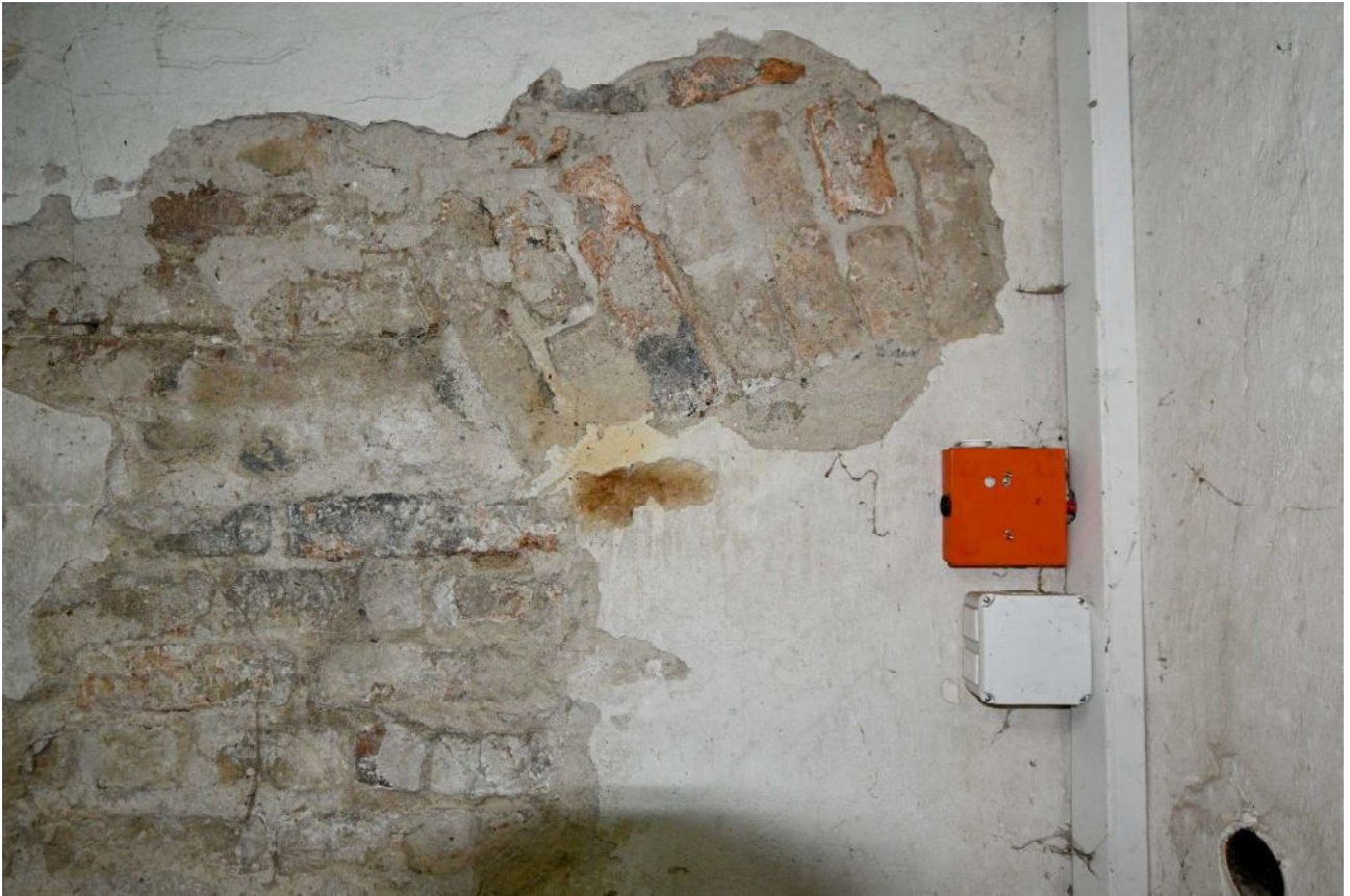
III/24. Oficyna dworu starostów międzyrzeckich, część A2, piwnice, pom. 01/12, ściana południowo-zachodnia odkrywka zamurowanego okna zwieńczonego łukiem odcinkowym grubości 1 cegły, faza II
