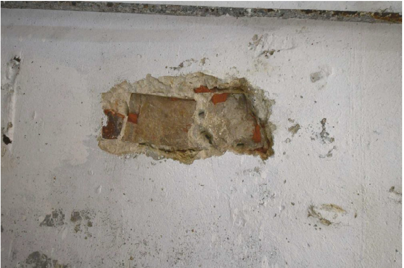
III/18. Oficyna dworu starostów międzyrzeckich, część A2, piwnice, pom. 01/9a, odkrywka w ścianie północno – wschodniej, ściana pod tynkiem szpałdowana dachówką z fazy II.
