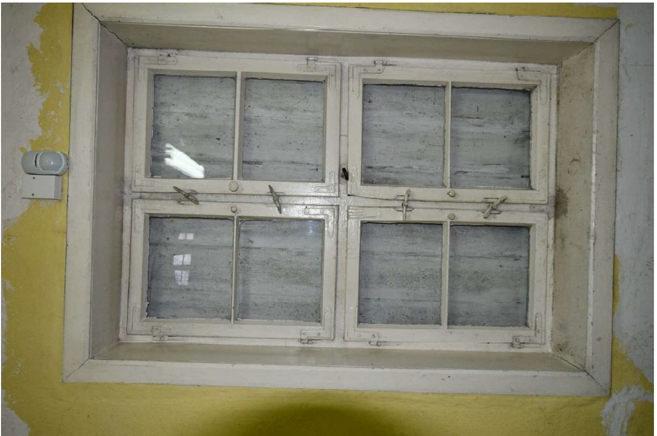
III/13. Oficyna dworu starostów międzyrzeckich, część B, parter, pom. K1, czworodzielna, krosnowa stolarka okienna, faza II, widok od wnętrza
