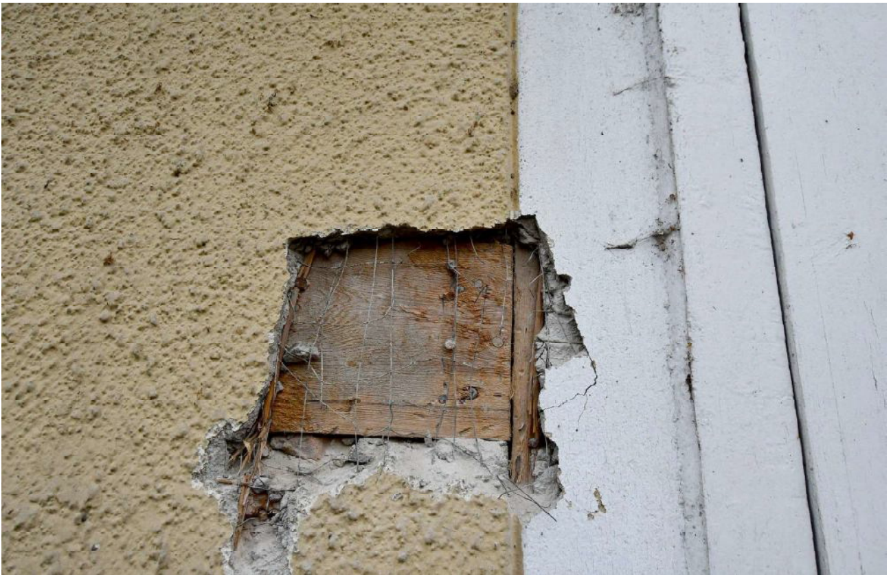
III/9. Oficyna dworu starostów międzyrzeckich, część B, elewacja północno – zachodnia, odkrywka częściowo uzupełnianej deską, konstrukcji szachulcowej przy północnej krawędzi okna pom. 0/9,
