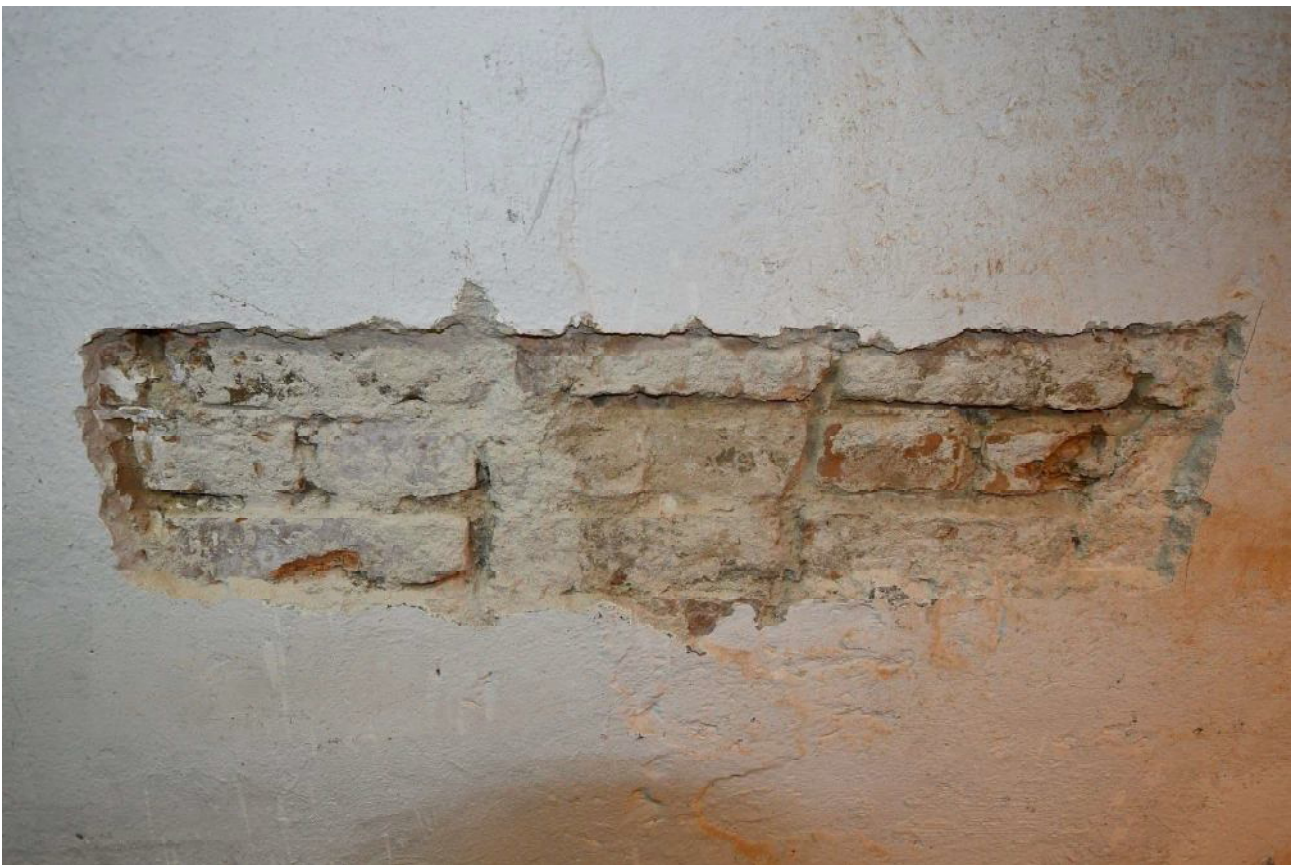
III/21. Oficyna dworu starostów międzyrzeckich, część A2, piwnice, pom. 01/9a,b, odkrywka na ścianie północno – wschodniej w miejscu usuniętej ściany działowej pomiędzy dawną częścią a i b,
