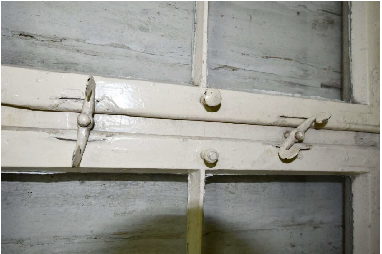
III/14. Oficyna dworu starostów międzyrzeckich, część B, parter, pom. K1, detal okuć krosnowej stolarki okiennej (gałki ■ antabki i motyłkowe zamknięcia skrzydeł okiennych), faza II
