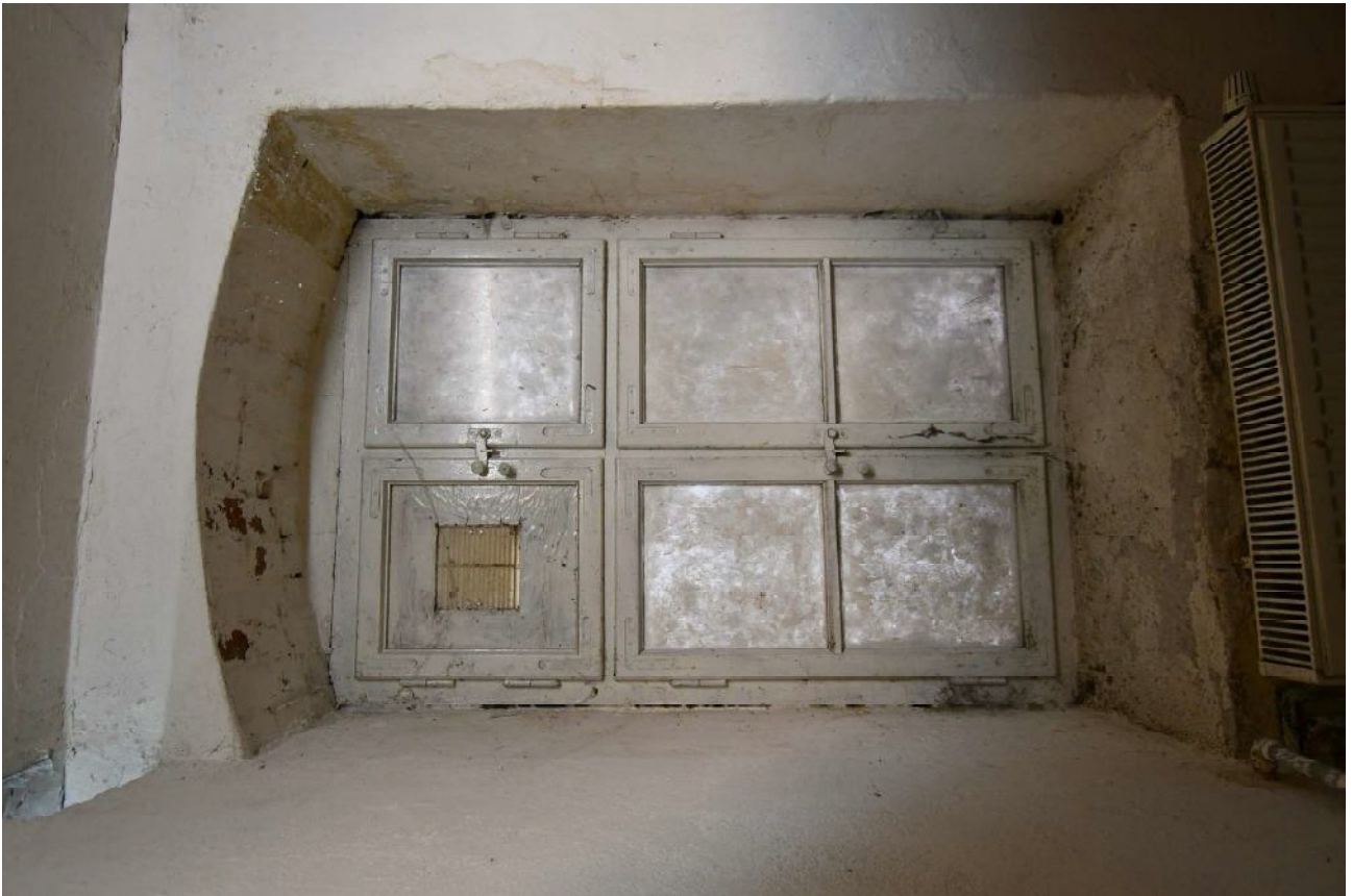
III/17. Oficyna dworu starostów międzyrzeckich, część B, piwnice, pom. 01/2, odcinkowo zwieńczona wnęka okienna i czterodzielna, krosnowa stolarka okienka piwnicznego z fazy III
