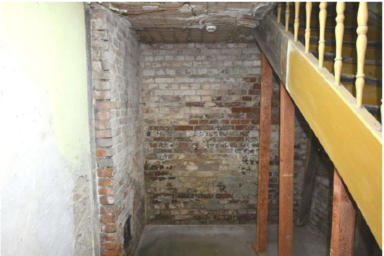
III/23. Oficyna dworu starostów międzyrzeckich, część B, piwnice, pom. K1, widoczne nieotynkowane ściany z cegieł ułożonych w wążku główkowo – wozówkowym,
