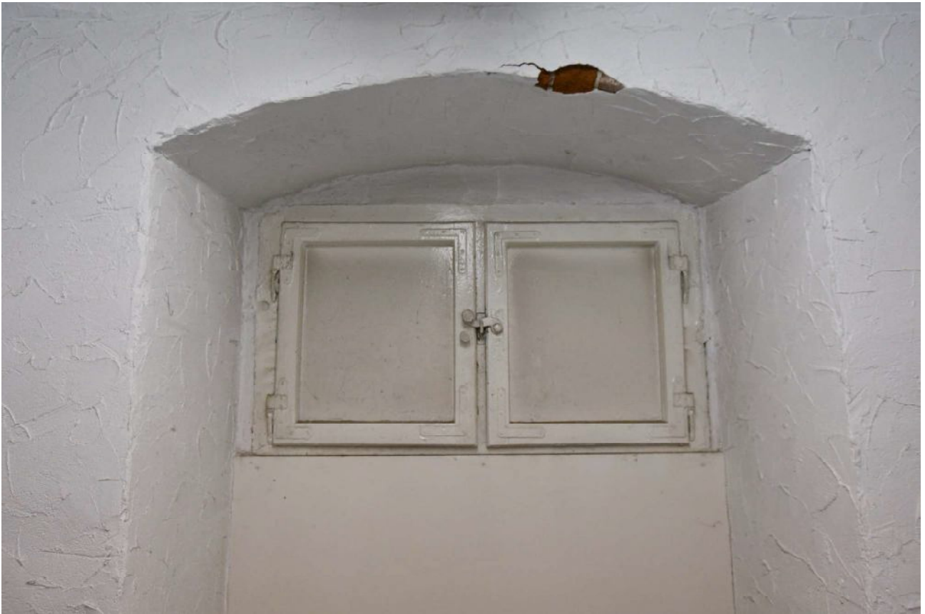
III/16. Oficyna dworu starostów międzyrzeckich, część B, piwnice, pom. 01/1, odcinkowo zwieńczona wnęka okienna i dwudzielna, krosnowa stolarka okienka piwnicznego z fazy III
