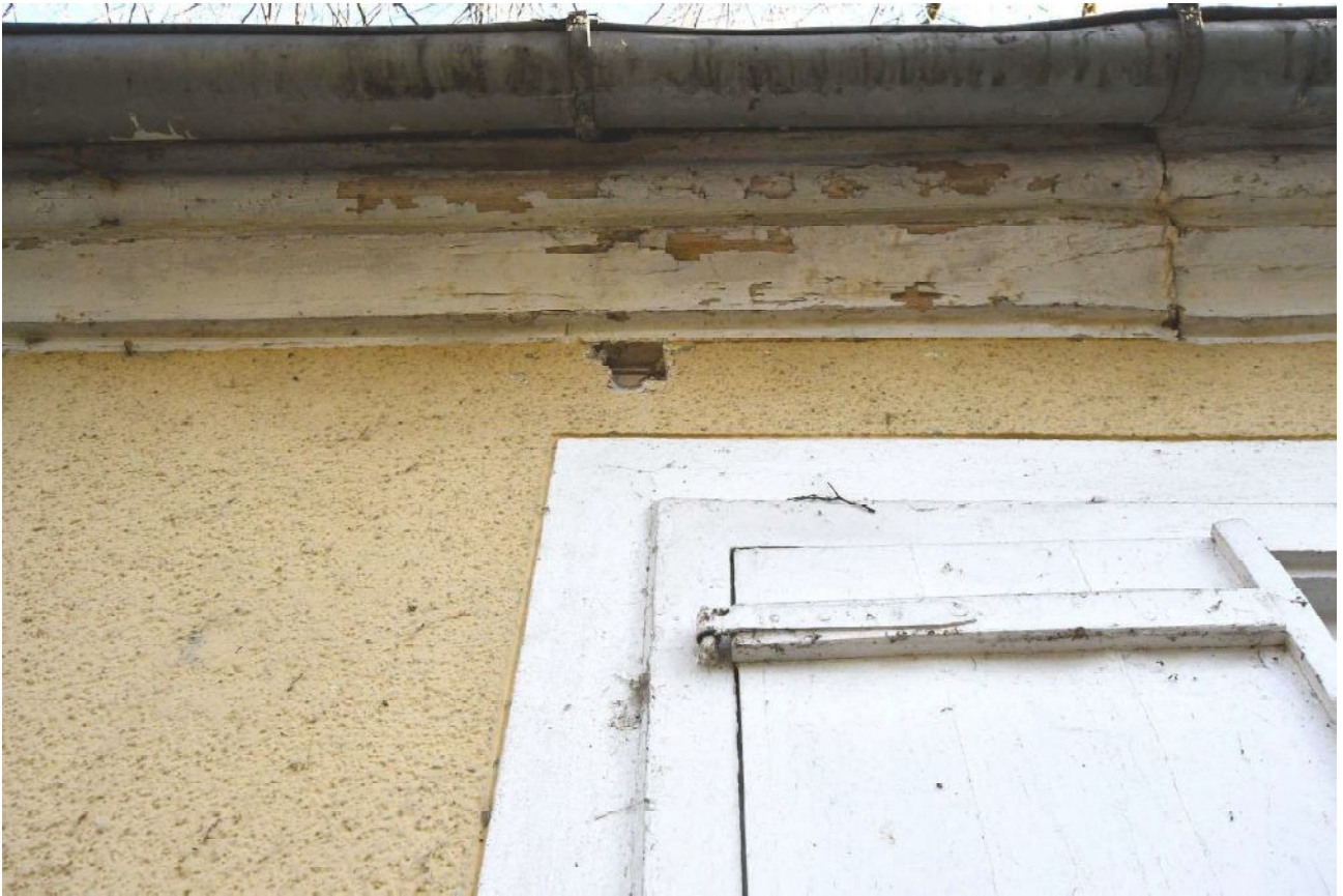
III/10. Oficyna dworu starostów międzyrzeckich, część B, elewacja północno – zachodnia, odkrywka częściowo zerodowanej, górnej belki konstrukcji szachulcowej ponad górnym, północnym narożnikiem okna pom. 0/9, powyżej belki zachowany drewniany, profilowany gzyms wieńczący, widoczne również wykończenie okna gładką, białą opaską tynkową i listwą drewnianą oraz detal okucia okiennicy (prosty zawias z łazy IV)
