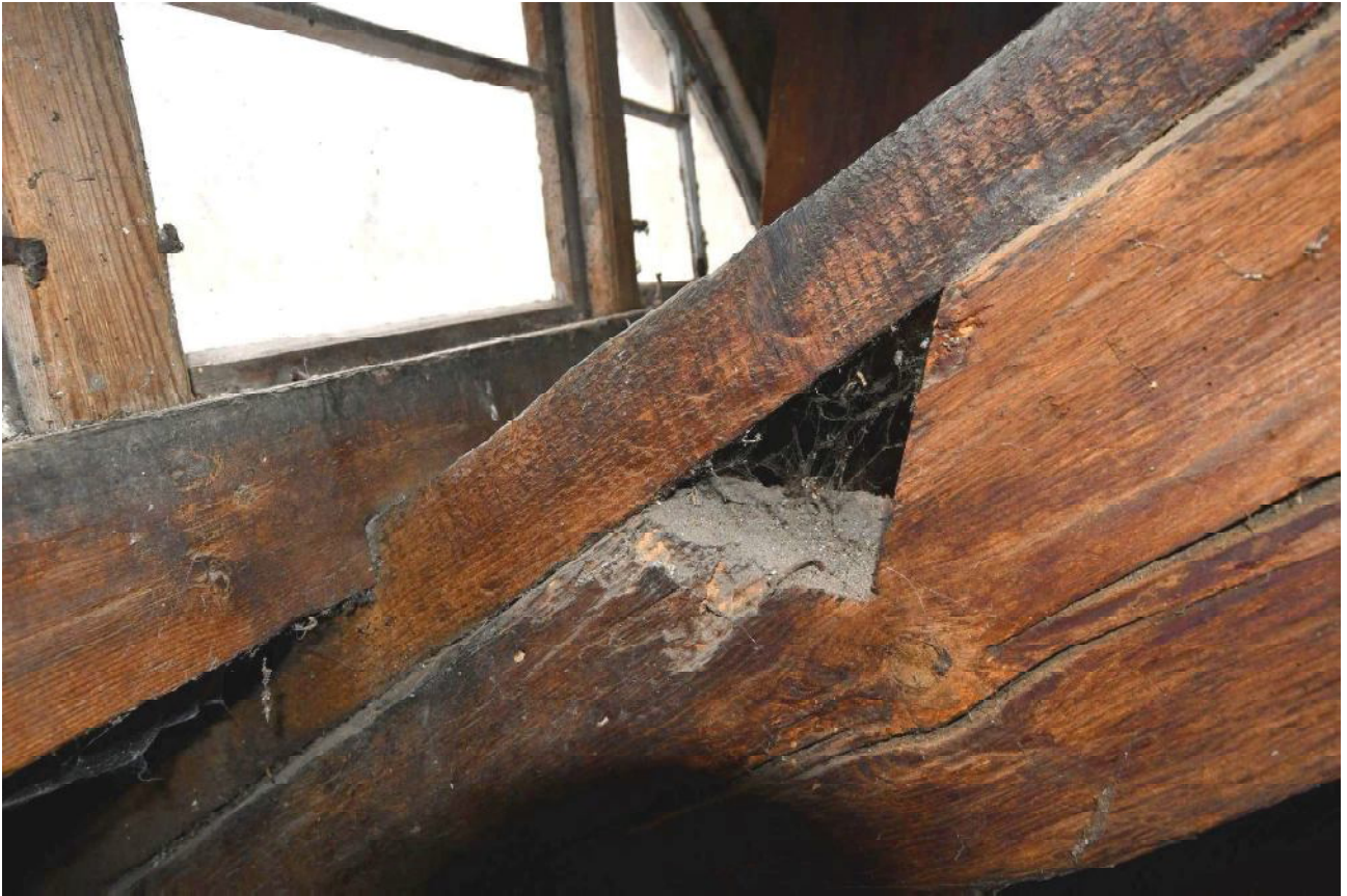
III/2. Oficyna dworu starostów międzyrzeckich, część B, poddasze, pom. 1/2, widoczne wycięcie w krokwi pod pierwotną lukarnę północno – zachodniej połaci dachowej, faza Ib, widoczna również niemalowana stolarka okna lukarny powiekowej z fazy II
