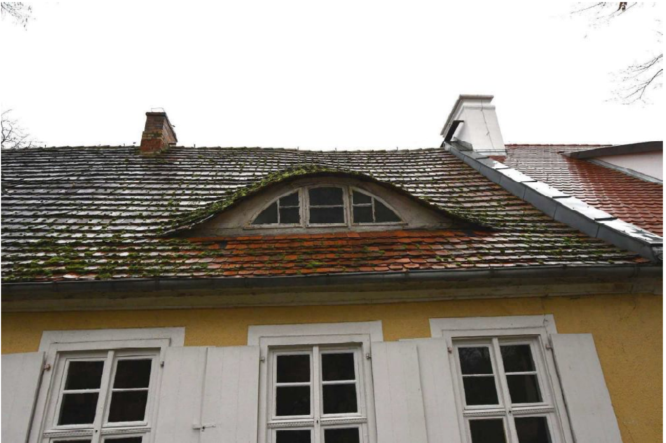
III/5. Oficyna dworu starostów międzyrzeckich, część B, elewacja północno – zachodnia, widok powiekowej lukarny dachowej (wrole oko), faza II
