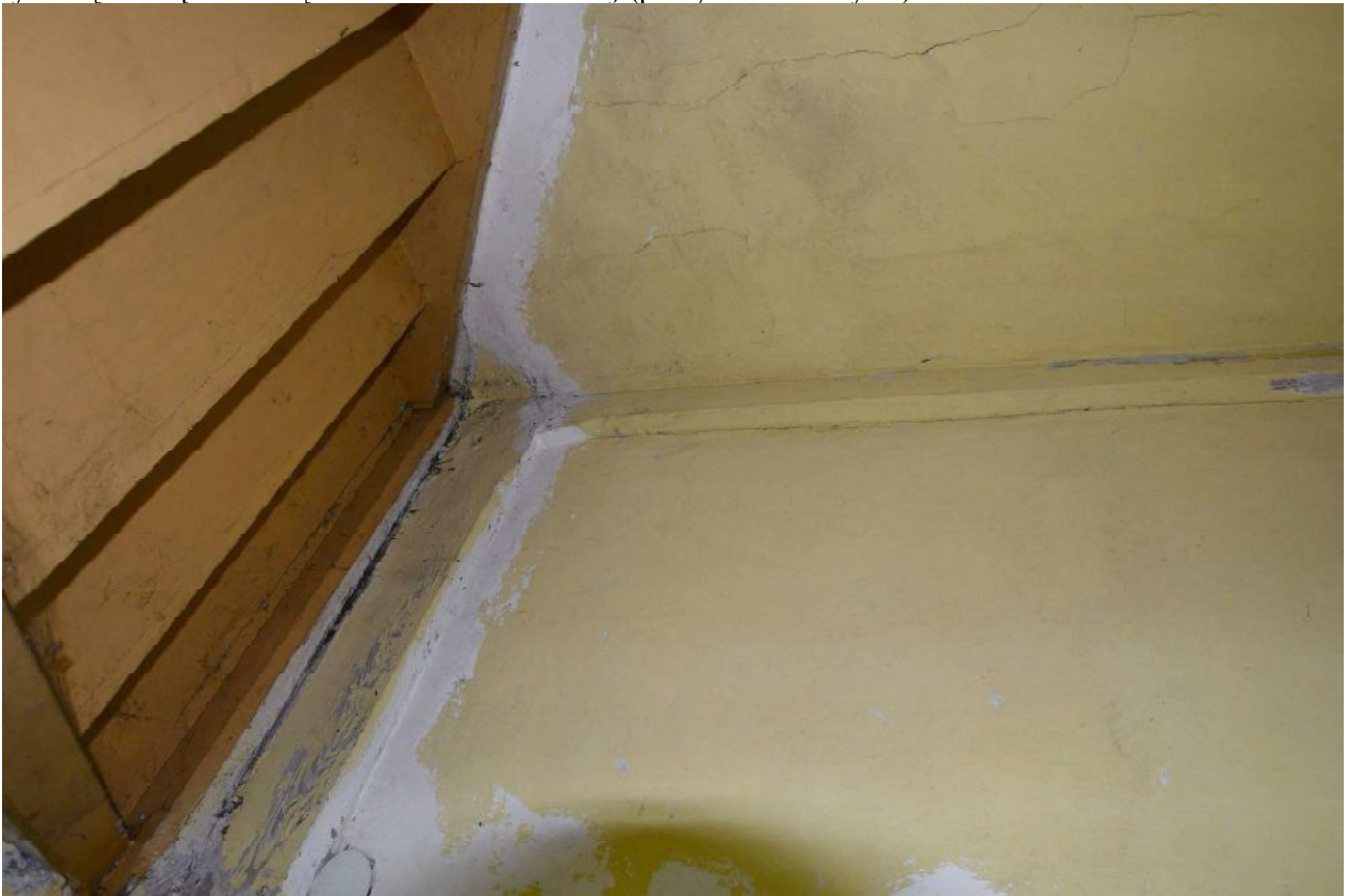
III/11. Oficyna dworu starostów międzyrzeckich, część B, parter, pom. K1, ścianka oddzielająca, klatkę schodową od przedsionka 0/2 widoczne drewniane elementy konstrukcji ścian wewnętrznych o sfazowanych i zakończonych śmigami narożnikami ( słup narożny i belka podciągu), faza Ib
