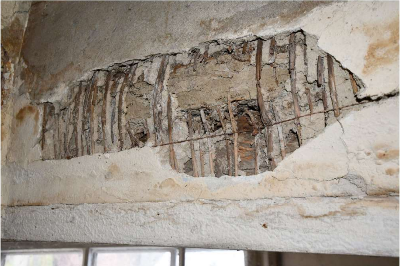
II/13. Oficyna dworu starostów międzyrzeckich, część B, poddasze, pom. 1/4, ocieplenie połaci dachowej glinobitką
