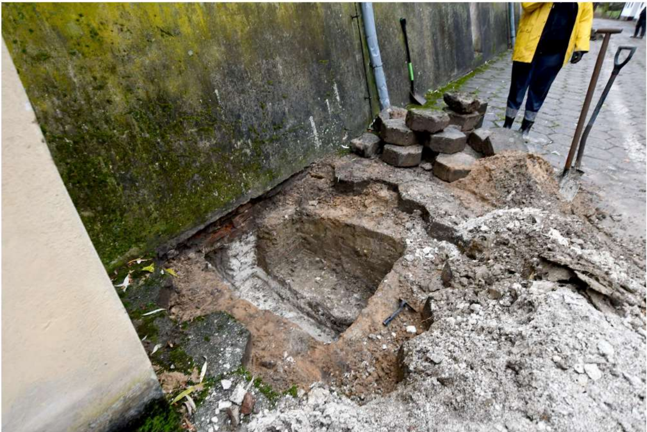
II/1. Oficina dworu starostów międzyrzeckich, wykop sondażowy A pod fundament niepodpiwniczonej części oficyny B
