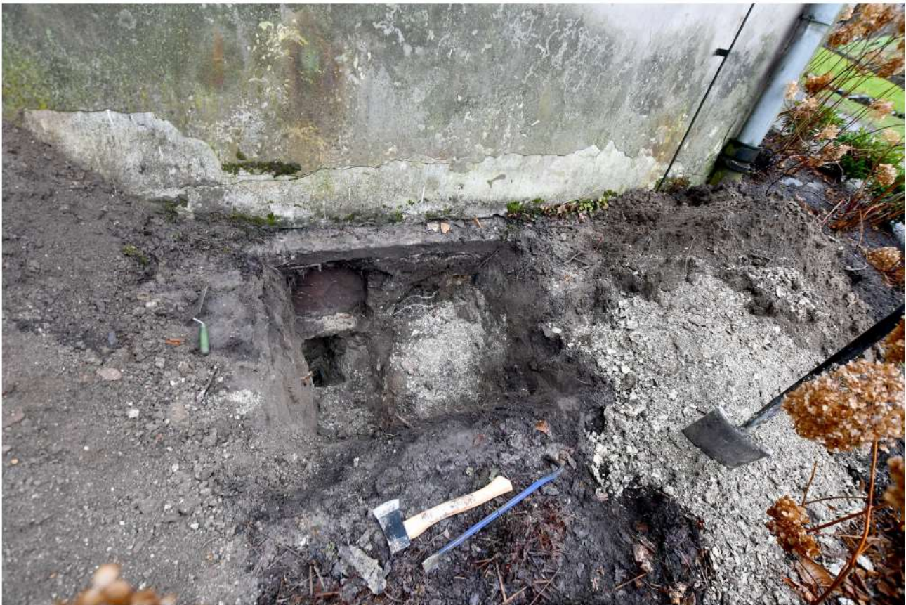
II/3. Oficyna dworu starostów międzyrzeckich, wykop sondażowy C pod fundament niepodpiwniczonej części oficyny B
