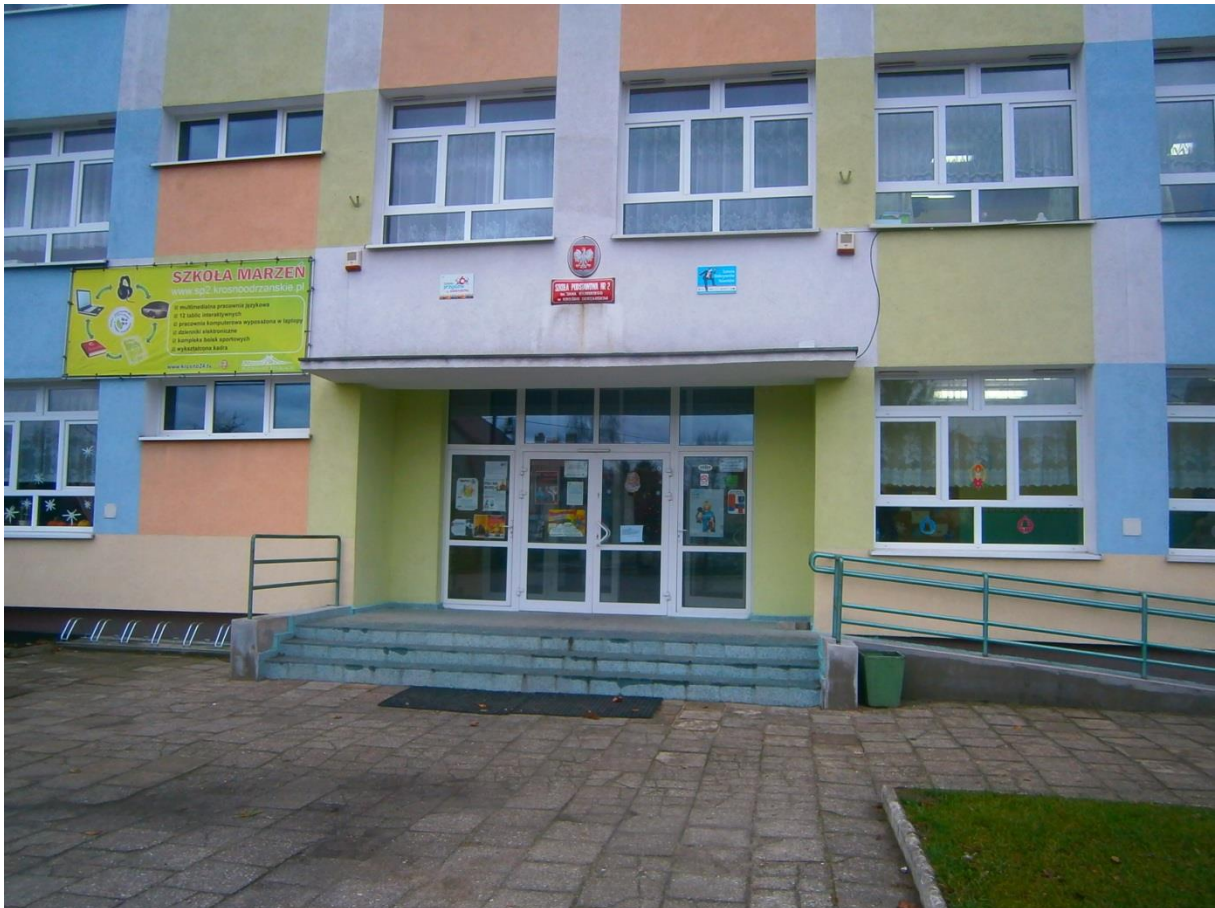
Zdj.1. Wejście główne budynku
