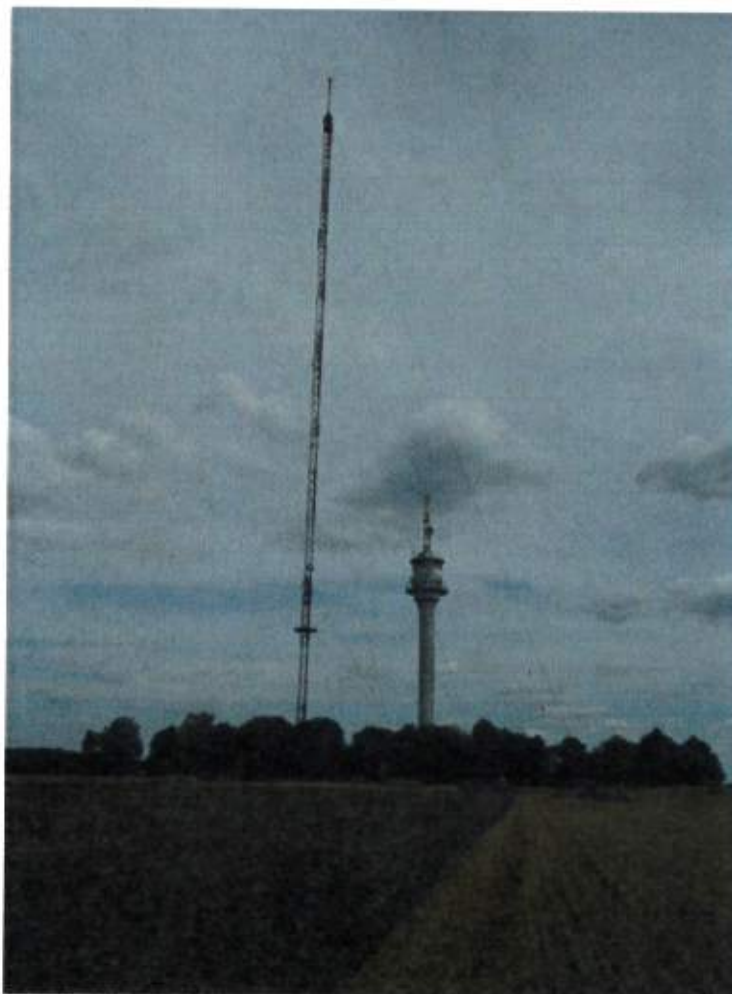
Zdjęcie 1 Badany obiekt
