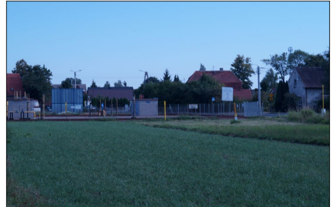
Zdj. 3 Widok na sąsiadujący teren infrastruktury technicznej – gazownictwa
