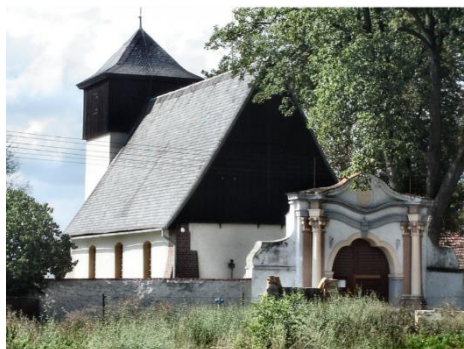
Fotografia 10. Widok na Kościół filialny pw. Narodzenia Najświętszej Marii Panny w Tylewicach.
