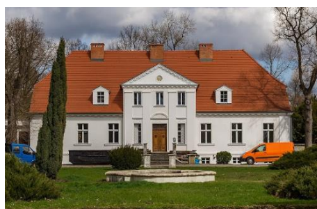
Fotografia 31. Widok na Dwór w Osowej Sieni.
