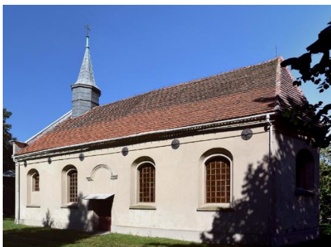
Fotografia 5. Widok na Kościół filialny pw. św. Jana Chrzciciela w Hetmanicach.
