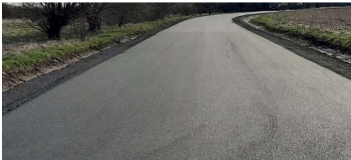
Zdjęcie 7 Przebudowa drogi powiatowej nr 1100F w m. Mielno
