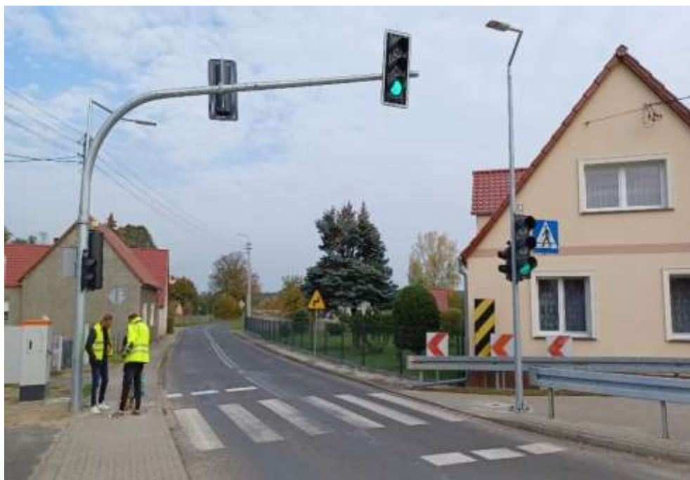
Zdjęcie 8 Przebudowa przejścia dla pieszych w miejscowości Tuplice
