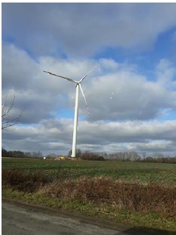
Elektrownia wiatrowa w Wichowie.
