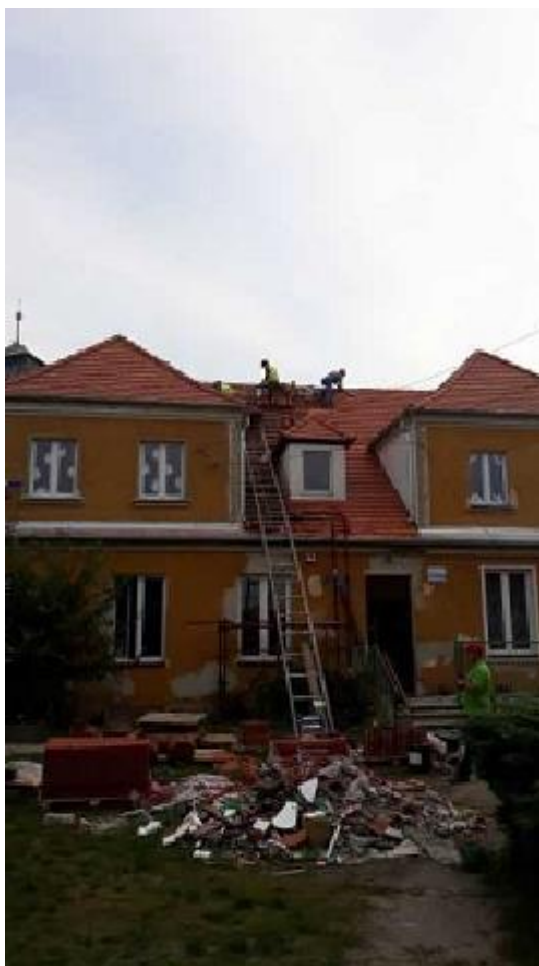
Remont dachu Szkoły Podstawowej w Brzeźnicy
