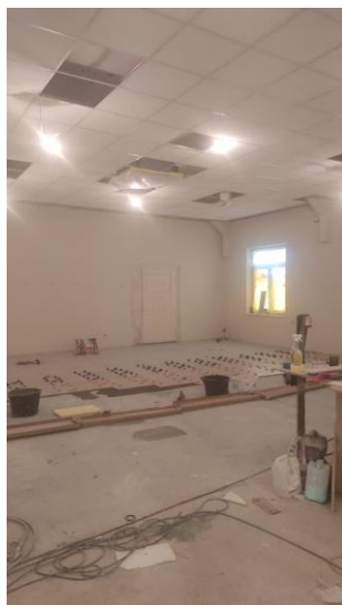
Fot. Remont świetlicy wiejskiej w miejscowości Wichów. Etap III obejmował: komin ,remont sufitu i podłogi , instalacje klimatyzatorów i urządzeń wentylacyjnych, remont sanitariatów oraz elewacji zewnętrznych.
