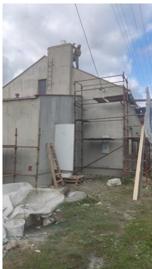
Fot. Remont świetlicy wiejskiej w miejscowości Wichów. Etap III obejmował: komin ,remont sufitu i podłogi , instalacje klimatyzatorów i urządzeń wentylacyjnych, remont sanitariatów oraz elewacji zewnętrznych.
