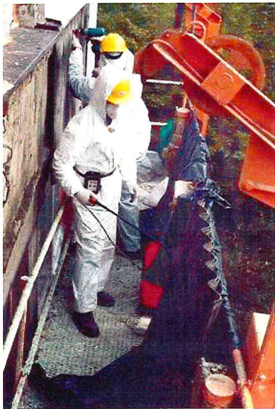
Rysunek 4 Usuwanie wyrobów azbestowych:
