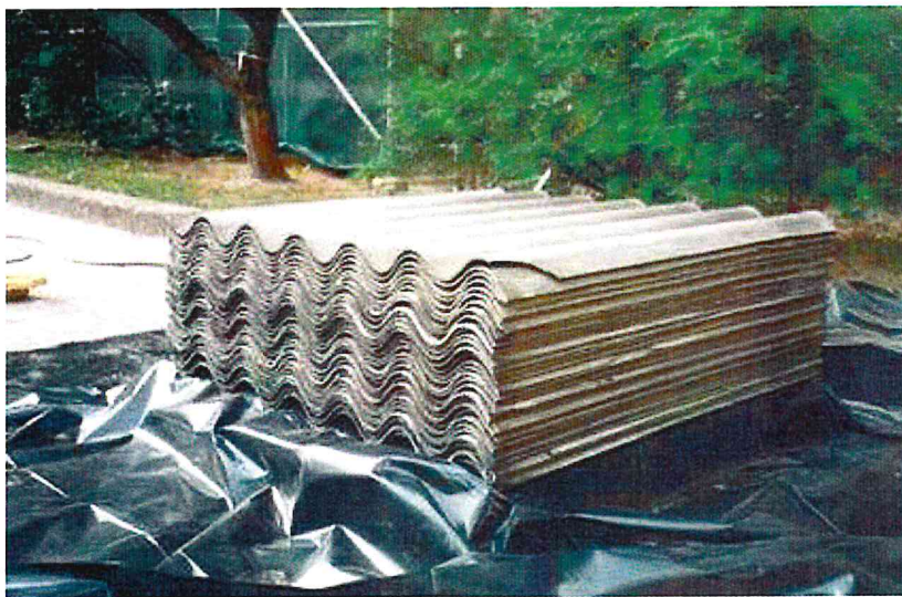
Rysunek 5 Przygotowanie wyrobów azbestowych do transportu:
