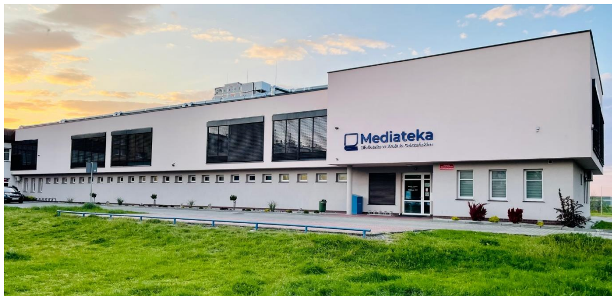
Fot. Budynek Mediateki przy ul. Pułaskiego, źródło: archiwum UM.
