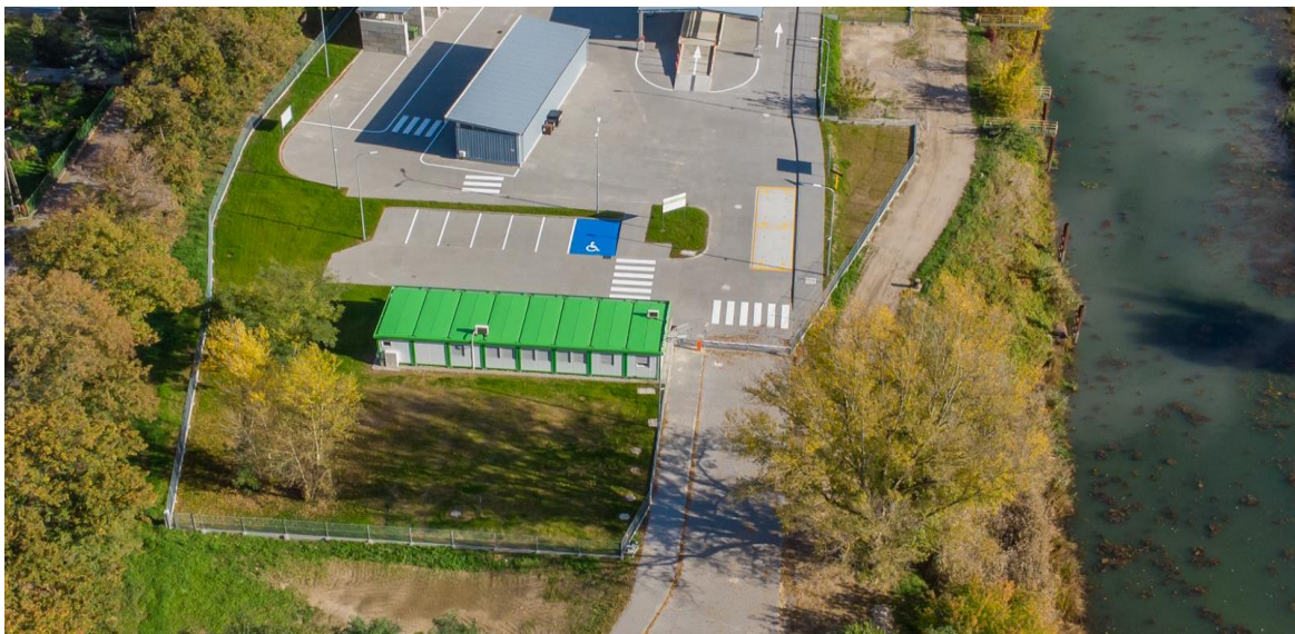
Fot. Droga dojazdowa do PSZOK przy ul. Wiejskiej, źródło: archiwum UM.
