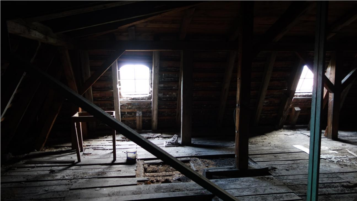
Fot. 6. Otwory okienne na poddaszu
