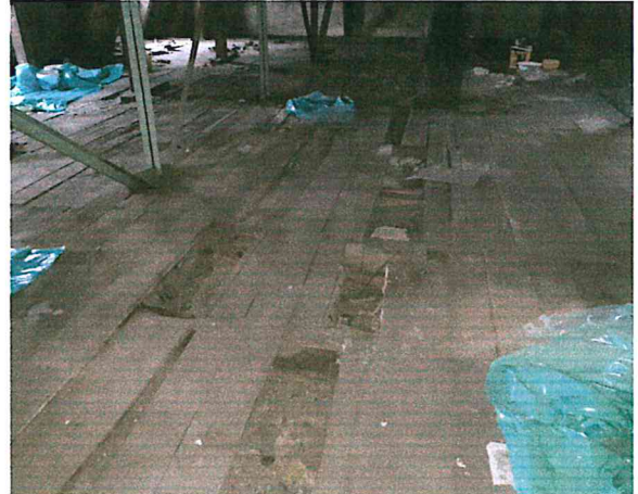
dziurawe deskowanie na belkach stropowych
