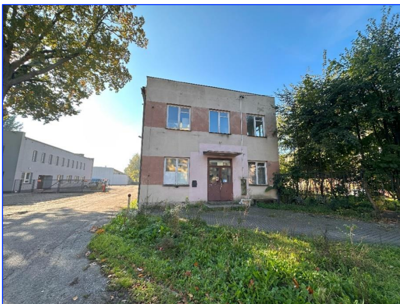
Ryc. 19 Nieużytkowany budynek przy ul. Pocztowej 30a
