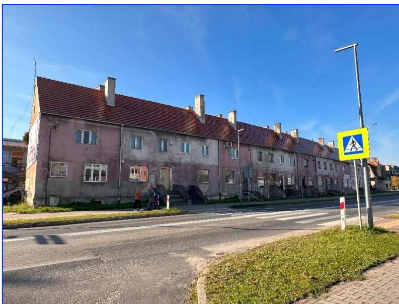
Ryc. 18 Budynek przy ul. Poznańskiej 8-30
