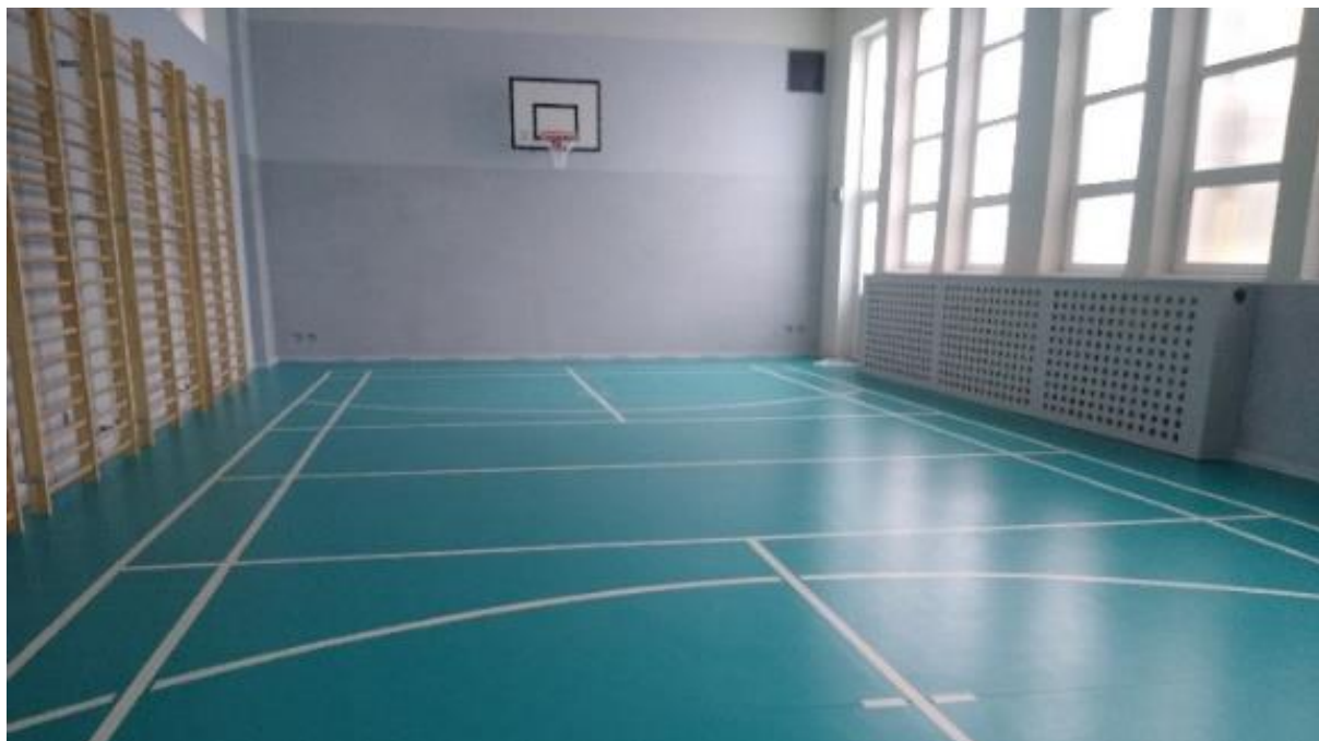
Fot. Sala gimnastyczna Zespołu Edukacyjnego w Osiecznicy po modernizacji, źródło: archiwum UM.
