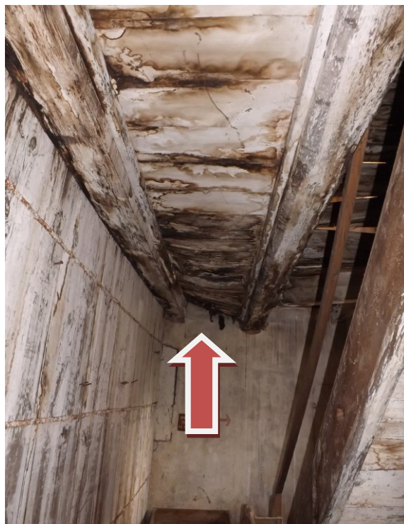
( Zdjęcie Nr 17. Klatka schodowa - widok podbitki korytarza /piętro/ ) .
