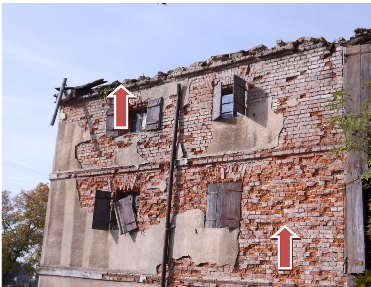
( Zdjęcie Nr 27. Widok gzymsu oraz elewacji frontowej budynku ) .
