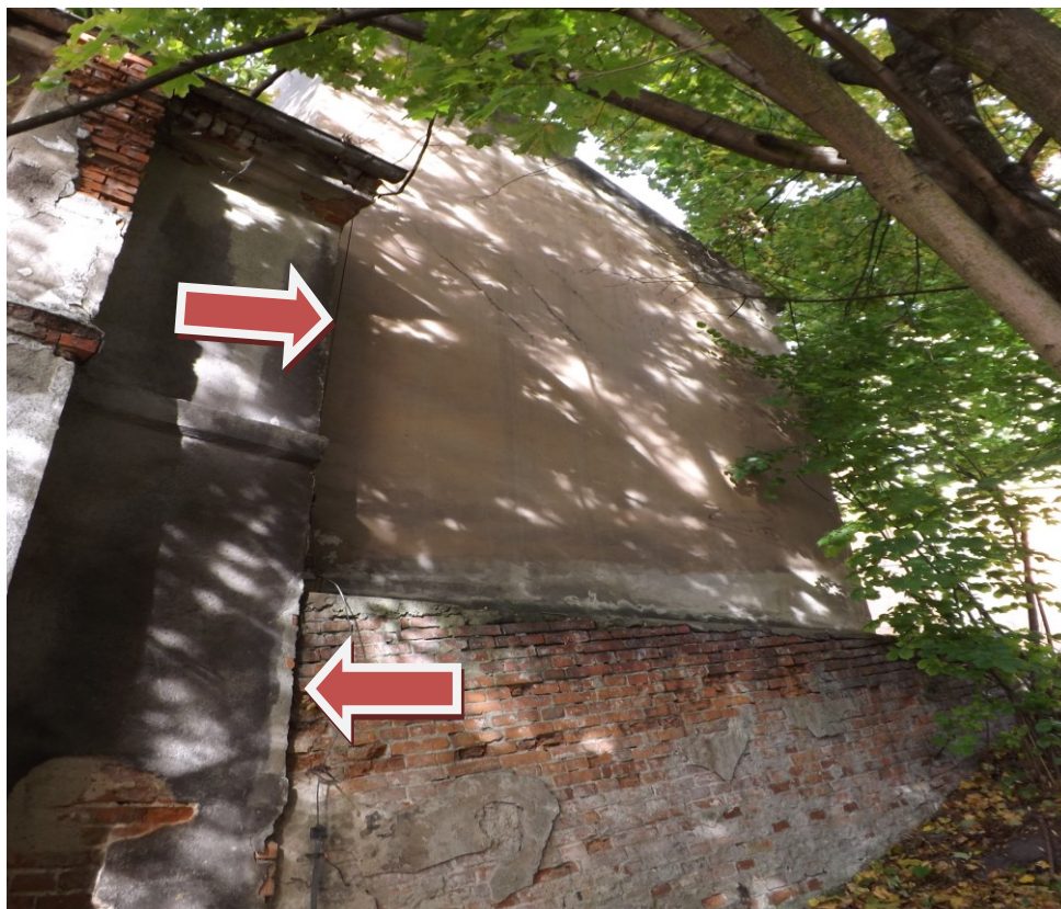
( Zdjęcie Nr 26. Widok wspólnej ściany z budynkiem z WOP 1B) .
