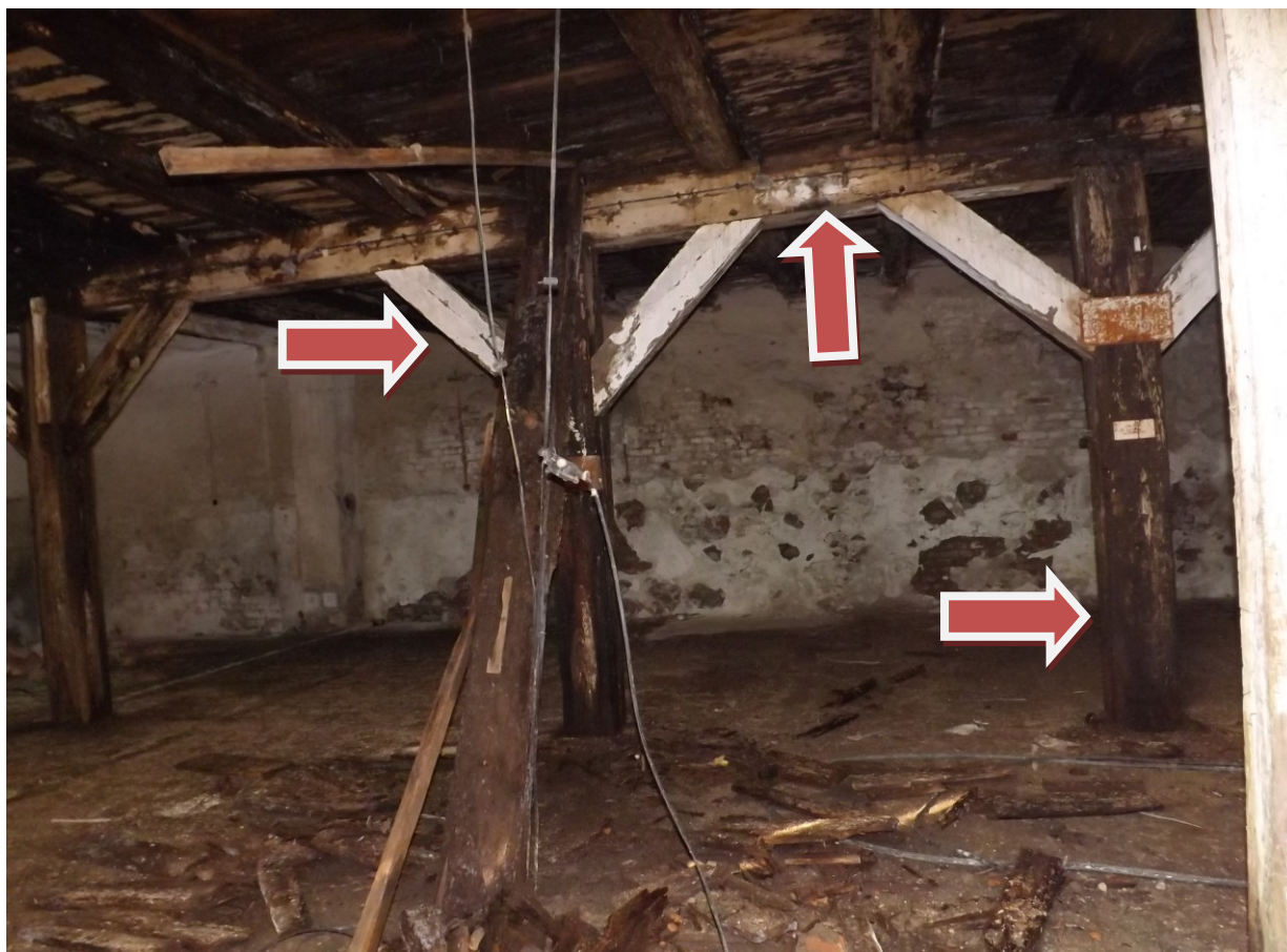
( Zdjęcie Nr 8. Strop piętra – widoczna belka drewniana oparta na słupach i mieczach ).
