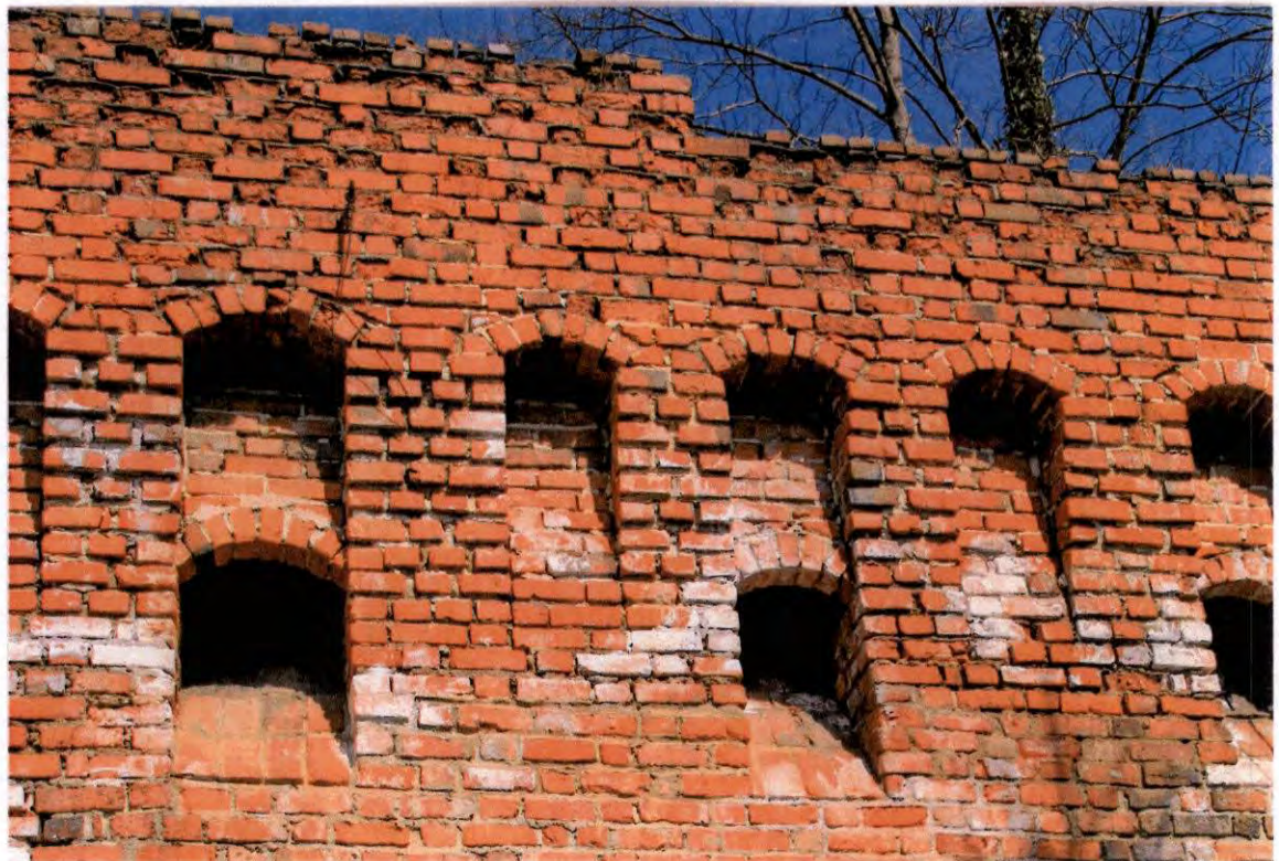
FOT. 16 - Ściana południowa strona zewnętrzna, fragment korony murów, widok ogólny.
