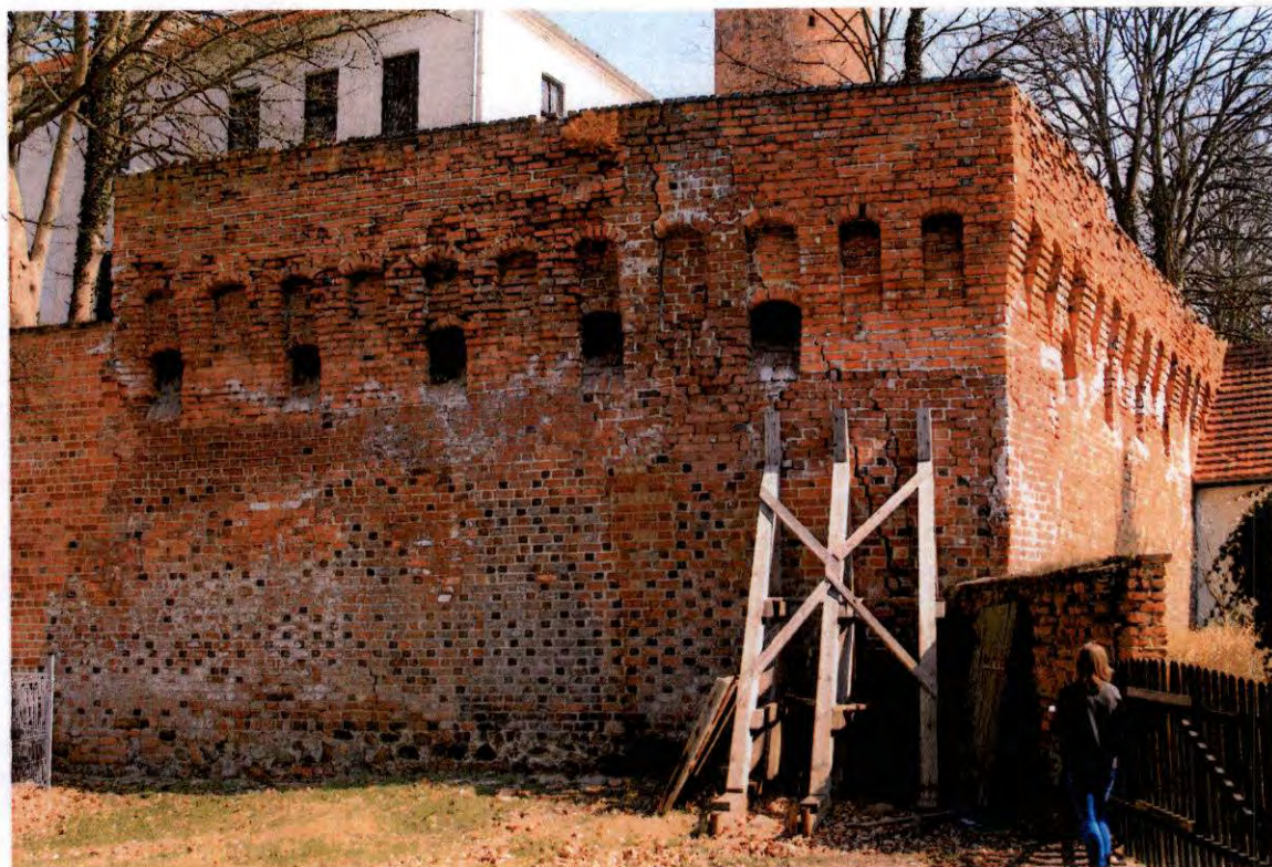
FOT. 17 - Ściana zachodnia, strona zewnętrzna, widok ogólny.
