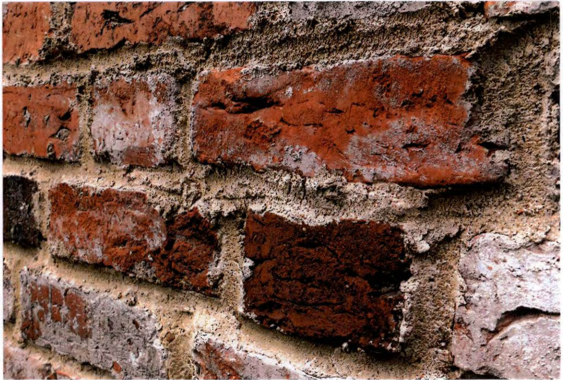
FOT. 15 - Ściana południowa strona zewnętrzna, odcinek po renowacji wykonanej w końcu XX w.
