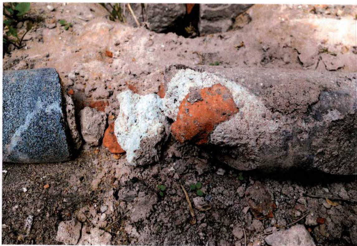
FOT. 5 – Detal fot. 4, fragmenty skał osadowych, zaprawy wiążącej z gruzem ceramicznym, miejsce pobrania próbki nr 1.
