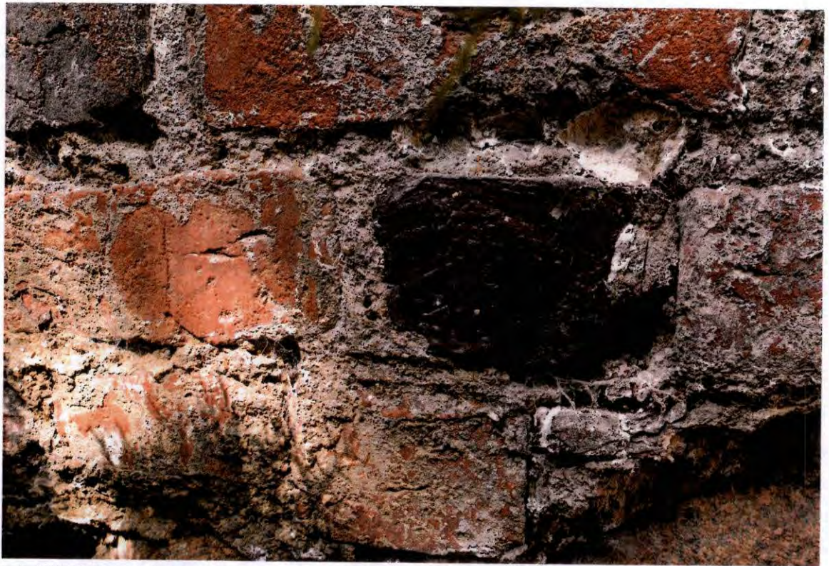
FOT. 9 - Ściana południowa strona zewnętrzna, odcinek środkowy przyziemie – fragment powierzchni zaprawy z widocznym oryginalnym opracowaniem powierzchni.
