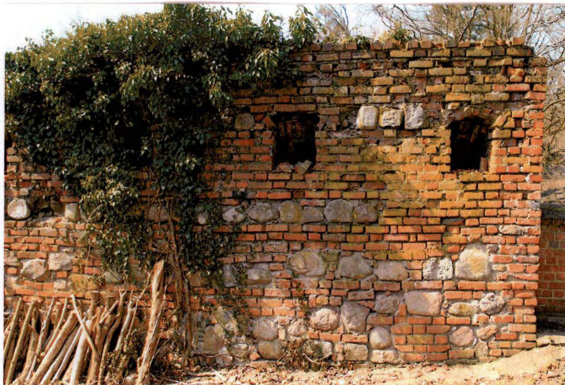
FOT. 30 - Ściana zachodnia, strona wewnętrzna , fragment.
