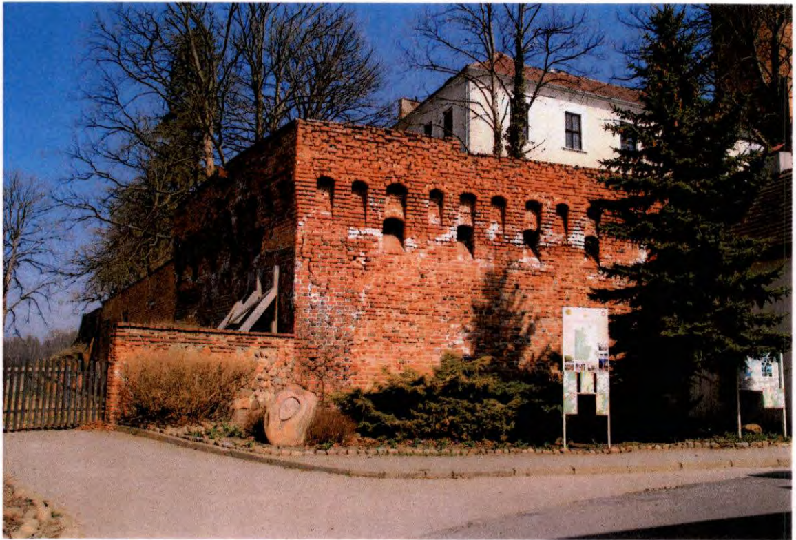
FOT. 3 – Ściana południowa strona zewnętrzna, widok ogólny.
