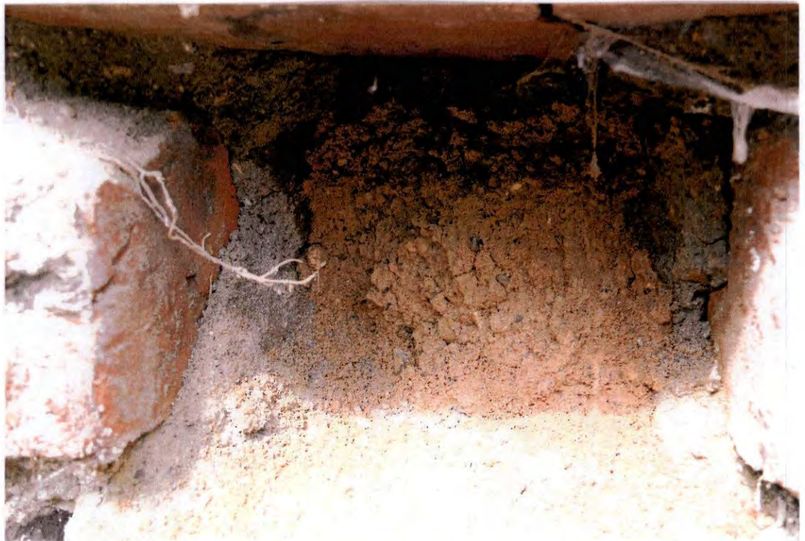
FOT. 13, 14 - Ściana południowa strona zewnętrzna, odcinek zachodni – fragmenty wypełnienia zaprawą w miejscu ubytku cegły. Wypełnienie tynkiem barwy kremowo ugrowej w otoczeniu zaprawy wapiennej barwy szarej.
