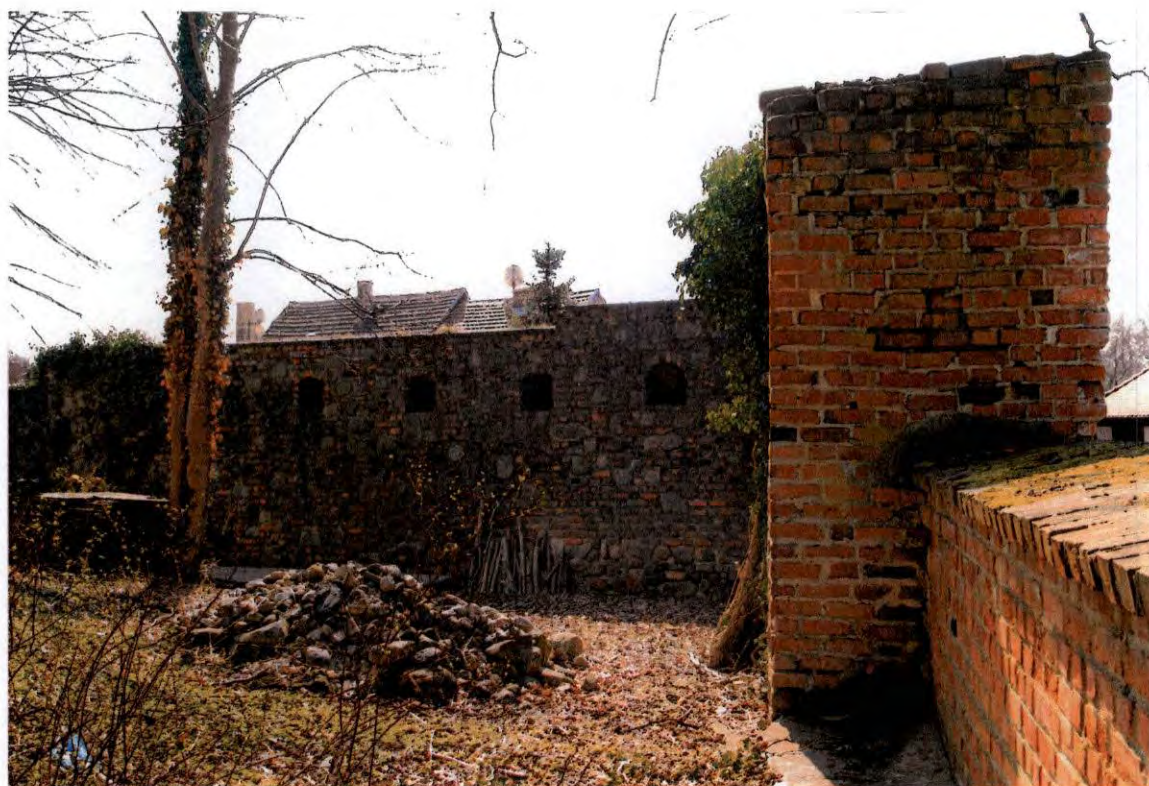
FOT. 29 - Ściana zachodnia (boczna) i ściana południowa, strona wewnętrzna – widok ogólny.
