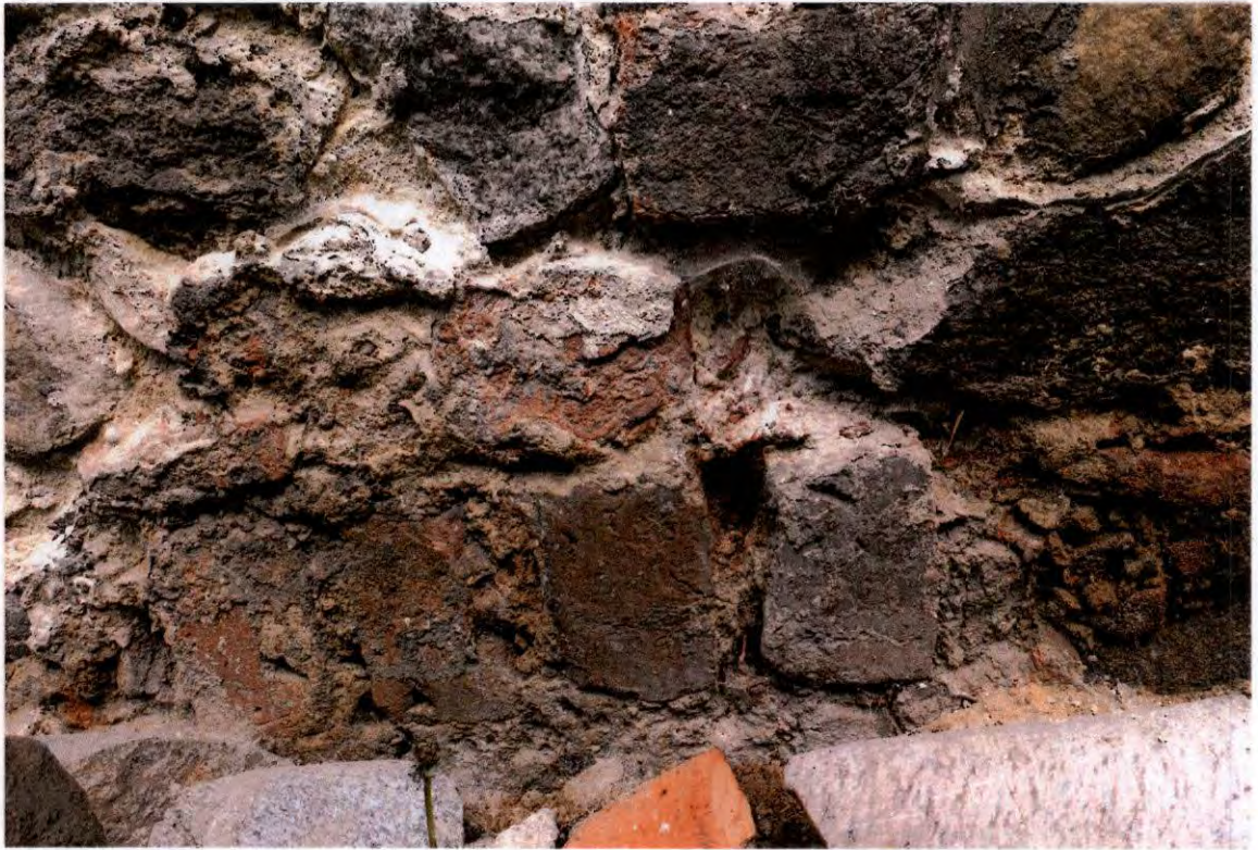
FOT. 21- Ściana zachodnia, strona zewnętrzna – strefa przyziemia w odcinku centralnym ściany. W dolnej części kadru widoczny fragment rdzenia przewiertu badań geotechnicznych – fragmenty skał i cegły spójone zaprawą wapienną. Miejsca pobrania próbek 9, 10
