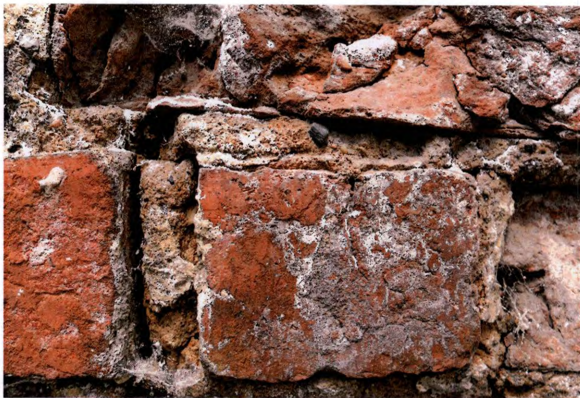
FOT. 7 - Ściana południowa strona zewnętrzna, odcinek wschodni – powierzchniowa warstwa spoiny kształtowanej analogicznie do zaprawy próbki nr 2.
