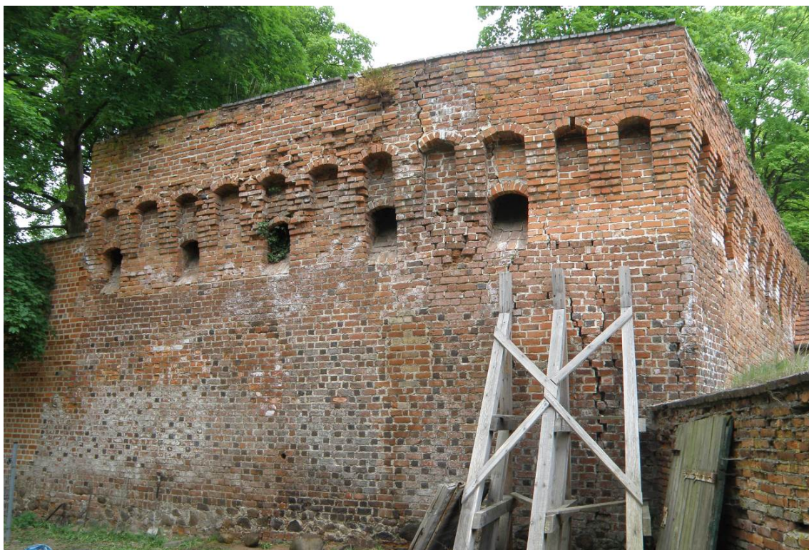
Fot. 2. Ścian zachodnia murów – dwa pionowe pęknięcia w odległości 1,30 m i 4,40 m
