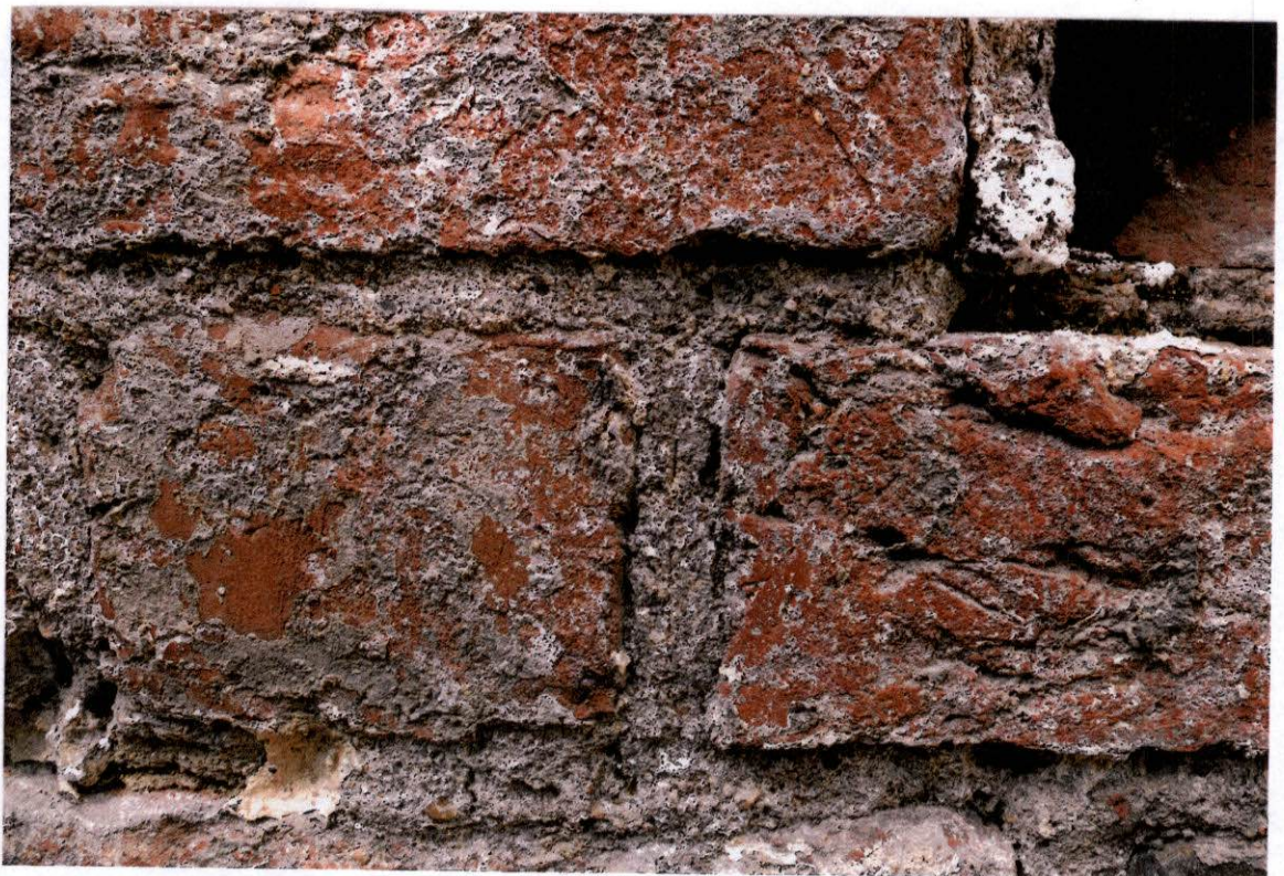
FOT. 10 - Ściana południowa strona zewnętrzna, odcinek w strefie przyziemia - zachowany relikwiar oryginalnej warstwy powierzchniowej spoiny ciętej.
