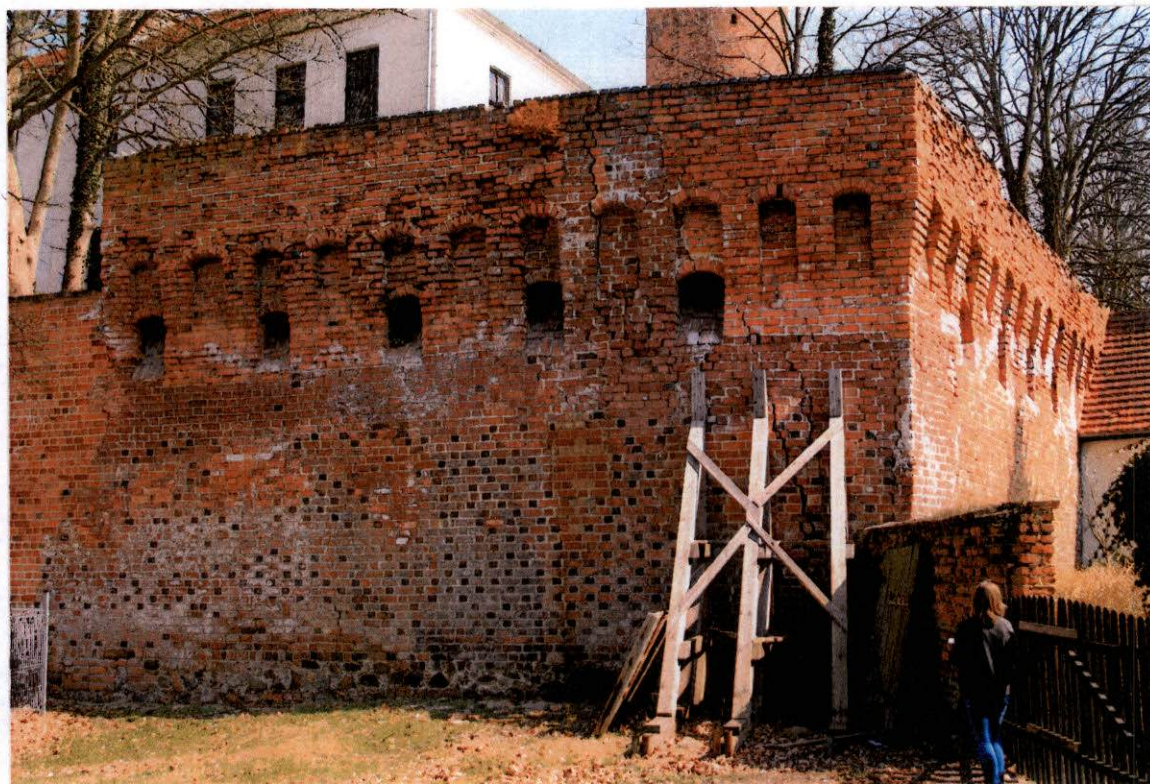
FOT. 17 - Ściana zachodnia, strona zewnętrzna, widok ogólny.
