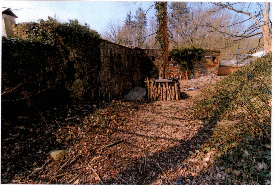
FOT. 2 - Narożnik południowo-zachodni murów obronnych, widok ogólny elewacji wewnętrznych w kierunku ściany zachodniej.
