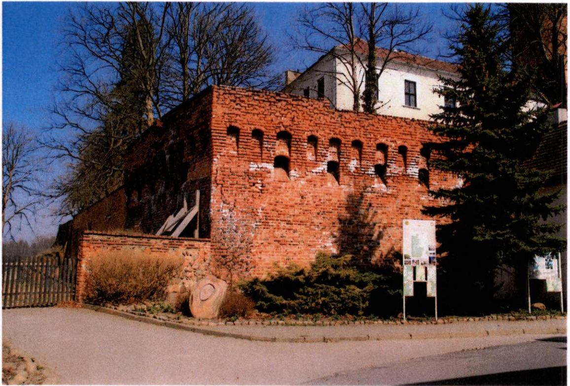
FOT. 3 – Ściana południowa strona zewnętrzna, widok ogólny.
