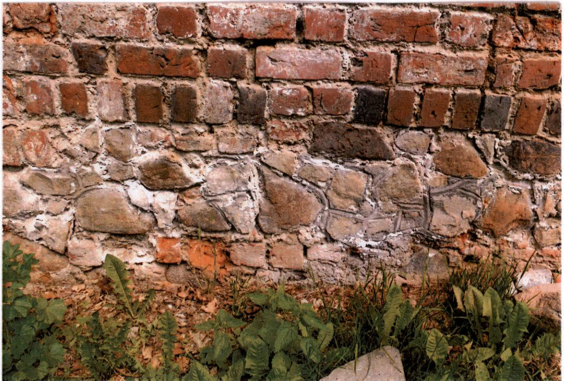
FOT. 20 - Ściana zachodnia, strona zewnętrzna – strefa przyziemia, fragment.
