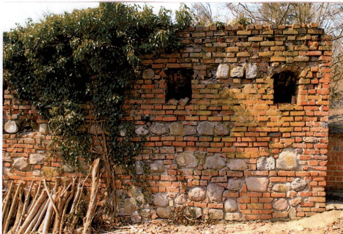
FOT. 30 - Ściana zachodnia, strona wewnętrzna , fragment.
