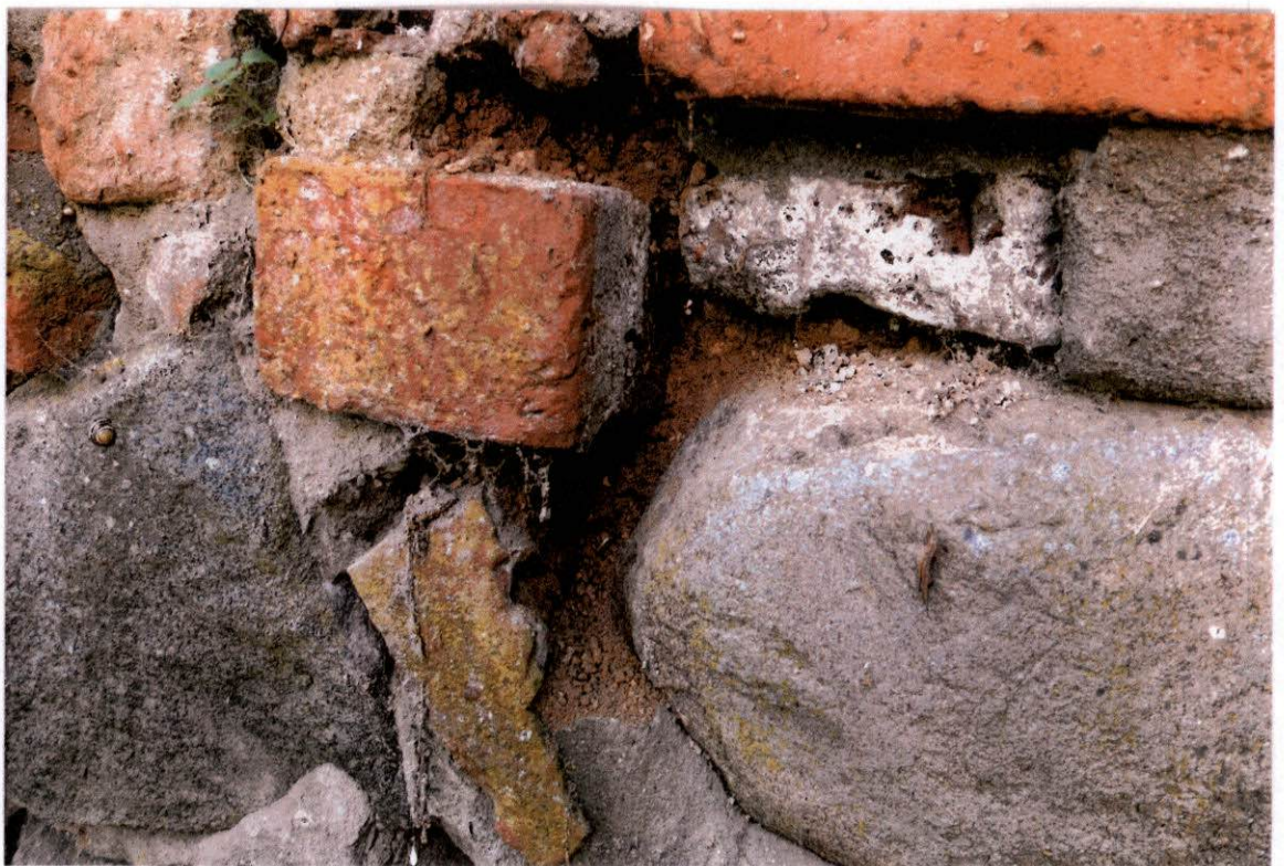
FOT. 32 - Ściana zachodnia, strona wewnętrzna , fragment w części podstawy odcinka południowego – miejsce pobrania próbki nr 13 reliktyw wcześniej zaprawy spoinującej
