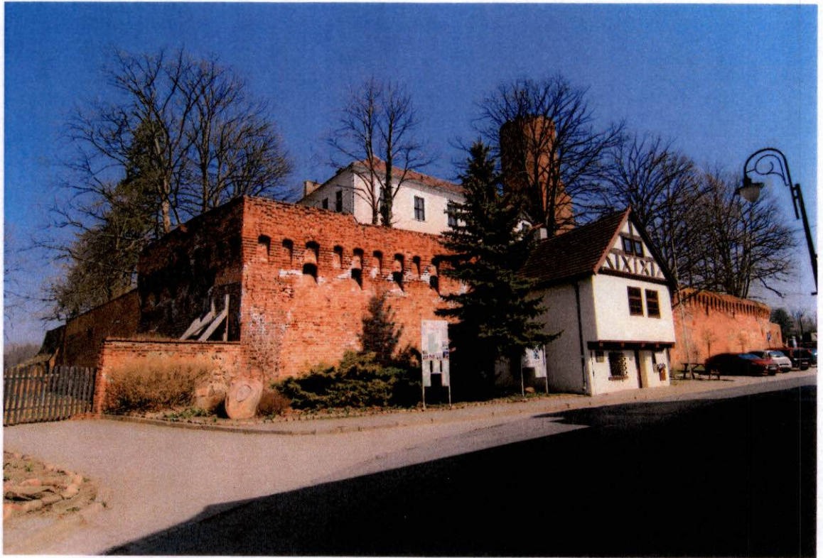
FOT. 1 – Narożnik południowo-zachodni murów obronnych, widok ogólny elewacji zewnętrznych.
