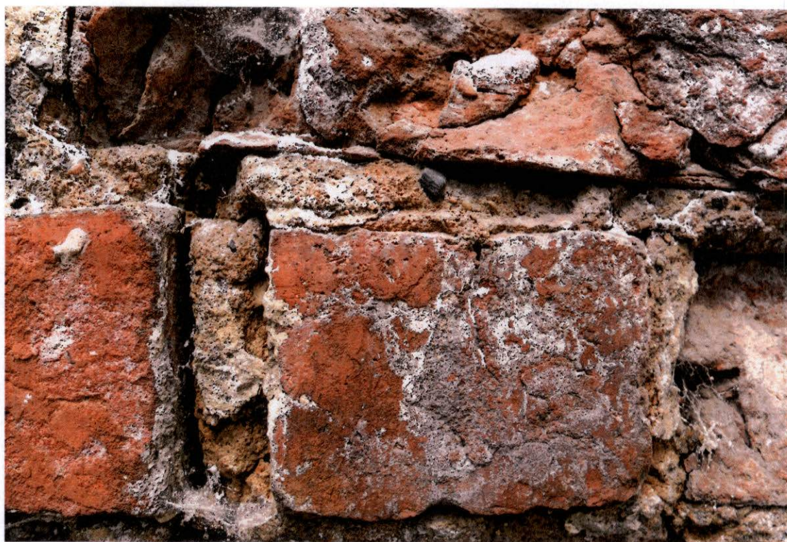
FOT. 7 - Ściana południowa strona zewnętrzna, odcinek wschodni – powierzchniowa warstwa spoiny kształtowanej analogicznie do zaprawy próbki nr 2.
