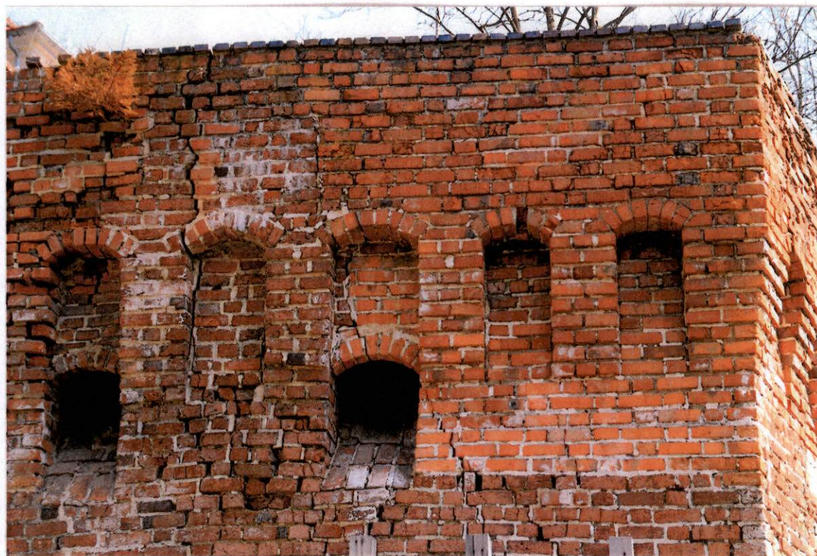
FOT. 18 - Ściana zachodnia, strona zewnętrzna – narożny fragment południowy zwieńczenia.
