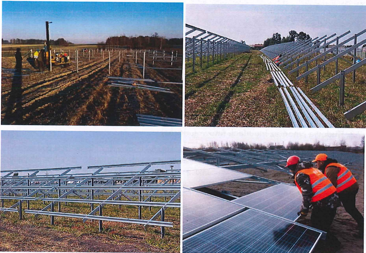
Rysunek 29. Budowa i montaż instalacji fotowoltaicznej
