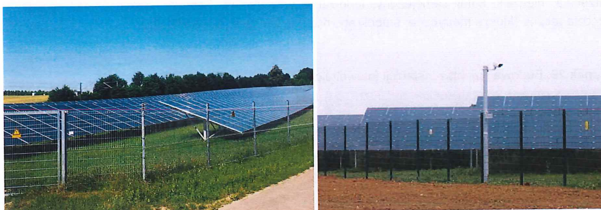
Rysunek 28. Ogrodzenie farmy fotowoltaicznej i system monitoringu
