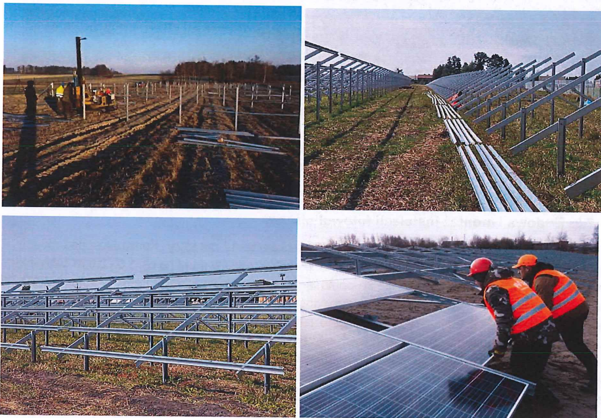
Rysunek 29. Budowa i montaż instalacji fotowoltaicznej
