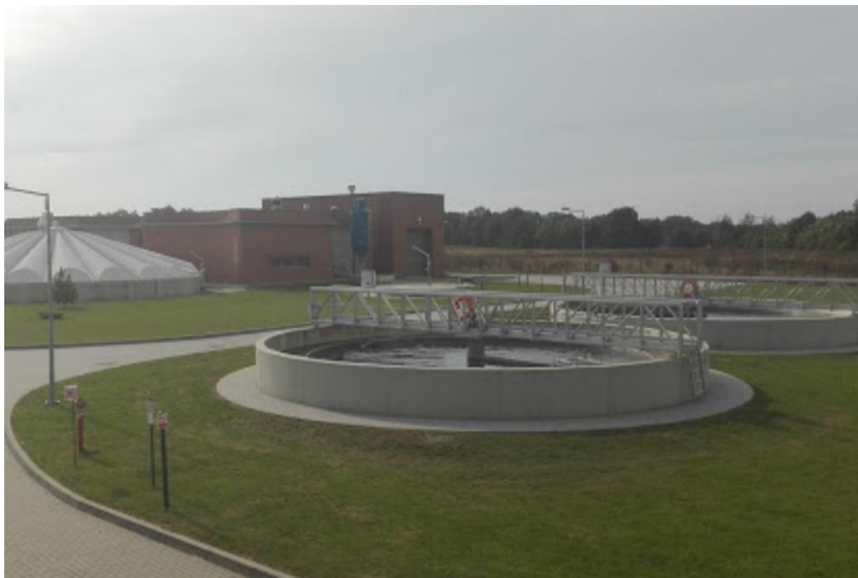
Zdjęcie 19 Oczyszczalnia ścieków w Wiechlicach
