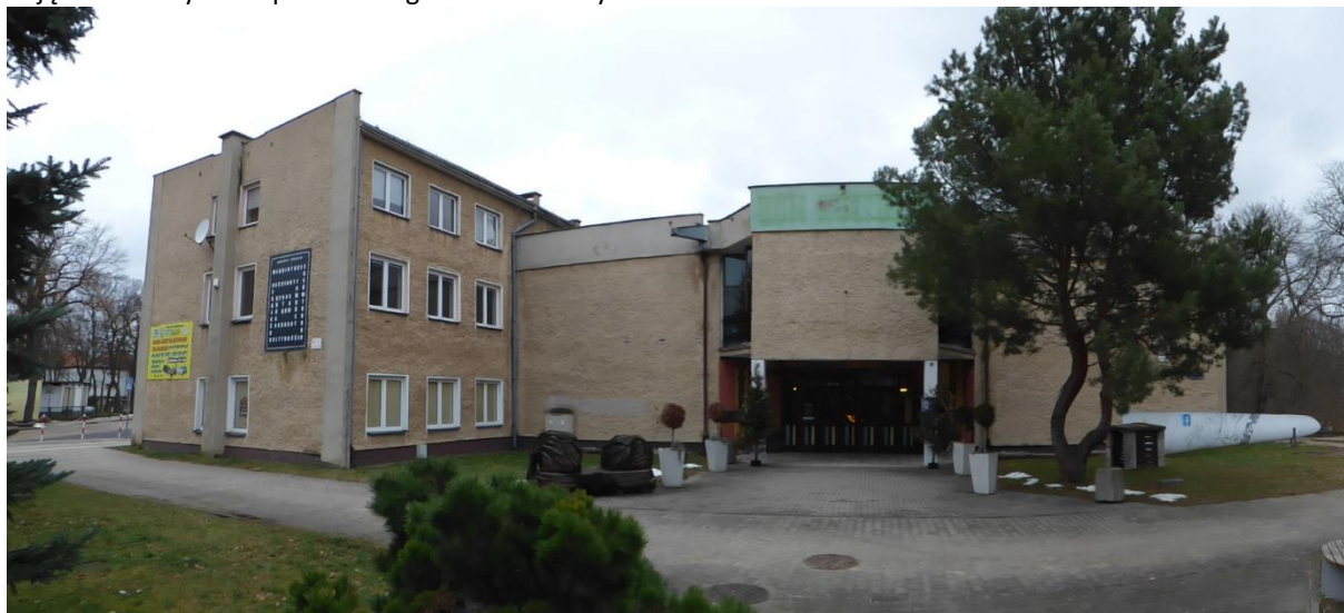
Zdjęcie 10 budynek Szprotawskiego Domu Kultury
