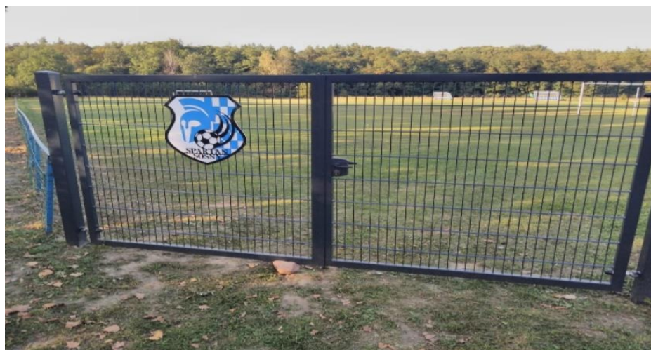
Poprawa infrastruktury boiska sportowego
