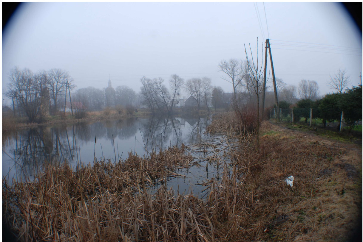
Fot. Nr 4 - Zbiornik małej retencji Z 1 - nr dz. 92/6 obręb Mościce
