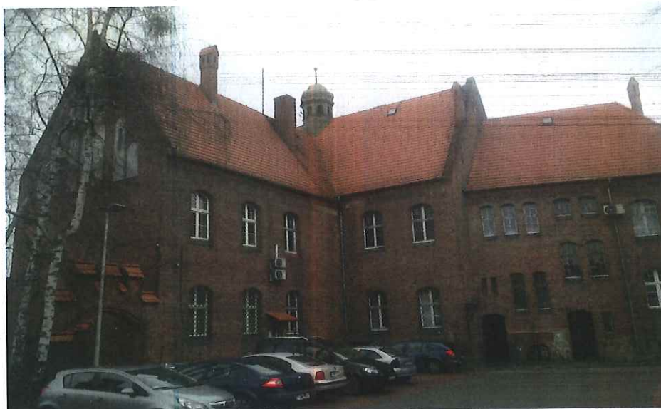
Fot. 2 – elewacja tylna
