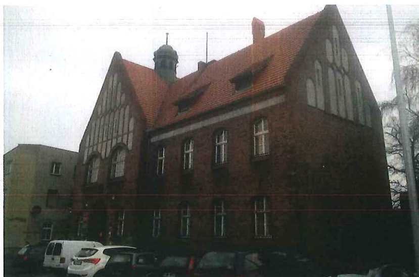
Fot. 1 – elewacja frontowa
