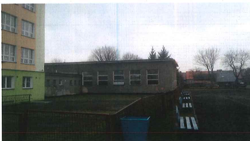
Fot. 2 – elewacja tylna
