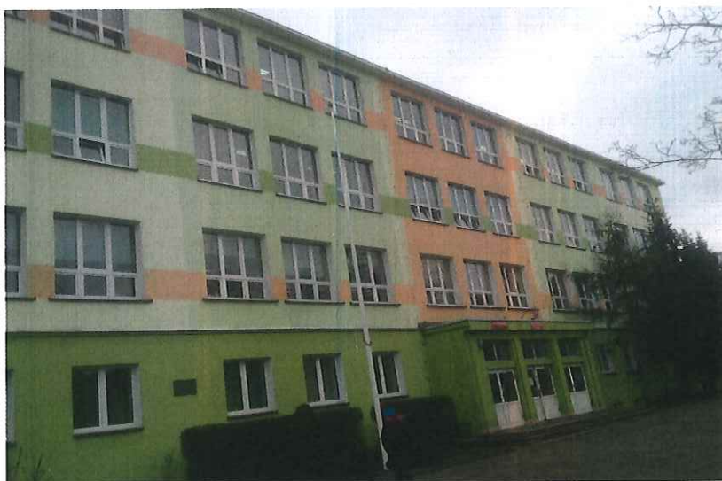
Fot. 1 – elewacja frontowa
