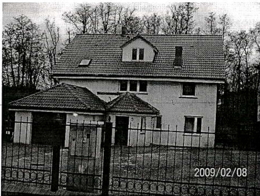
Wyremontowany dom przy ul. Młyńskiej.
