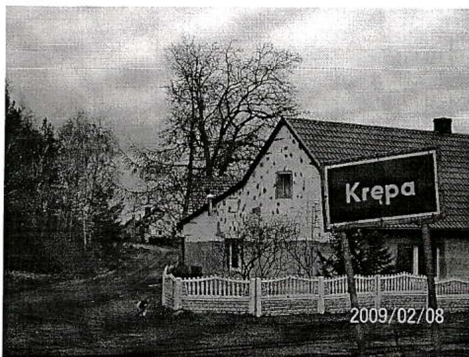
Dom w trakcie remontu przy wjeździe do Krępy od strony Łęczycy.
