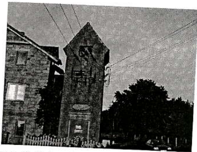
Rys. 13. Trafostacja w Drzonkowie
