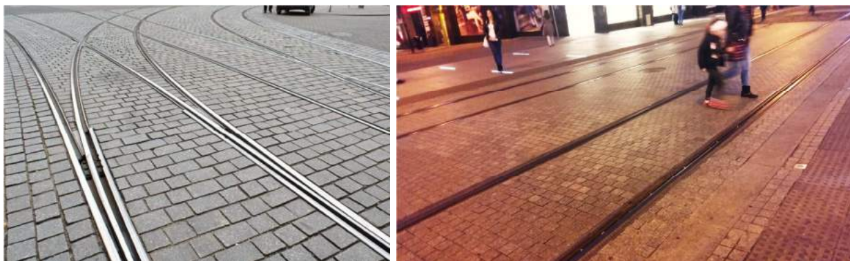
Ryc. 47. Uszlachetnione nawierzchnie płyt torowiska – przykłady rozwiązań zalecanych: Gdańsk i Katowice
