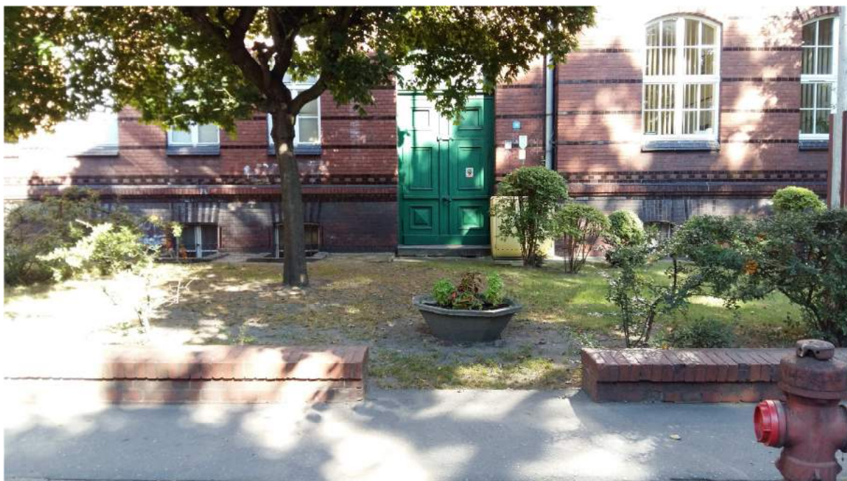
Ryc. 48. Budynek szkoły ekonomicznej przy ul. 30. Stycznia z nieczynnym głównym wejściem od strony ulicy
