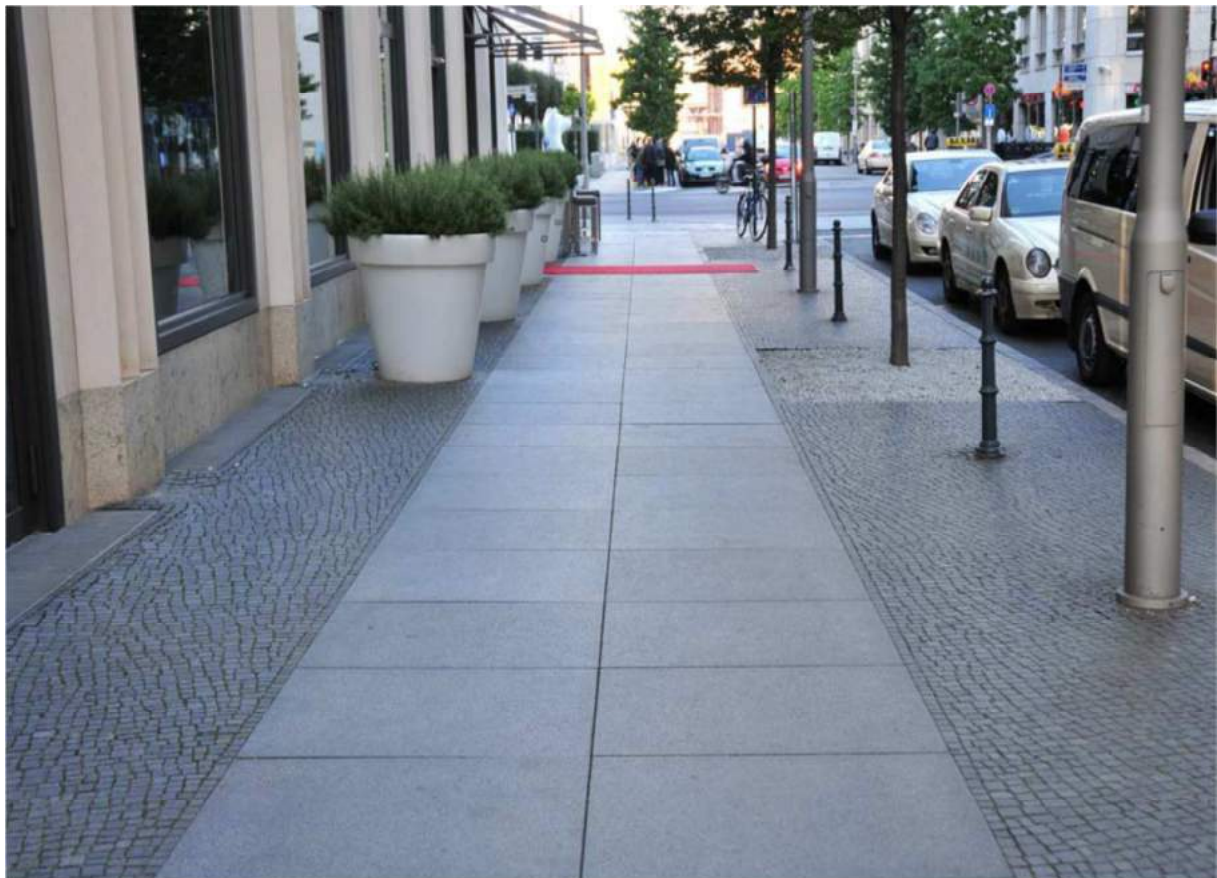
Ryc. 41. Zasada trójpasowego kształtowania chodników – przykład
