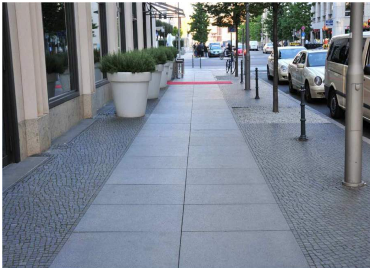
Ryc. 41. Zasada trójpasmowego kształtowania chodników – przykład
