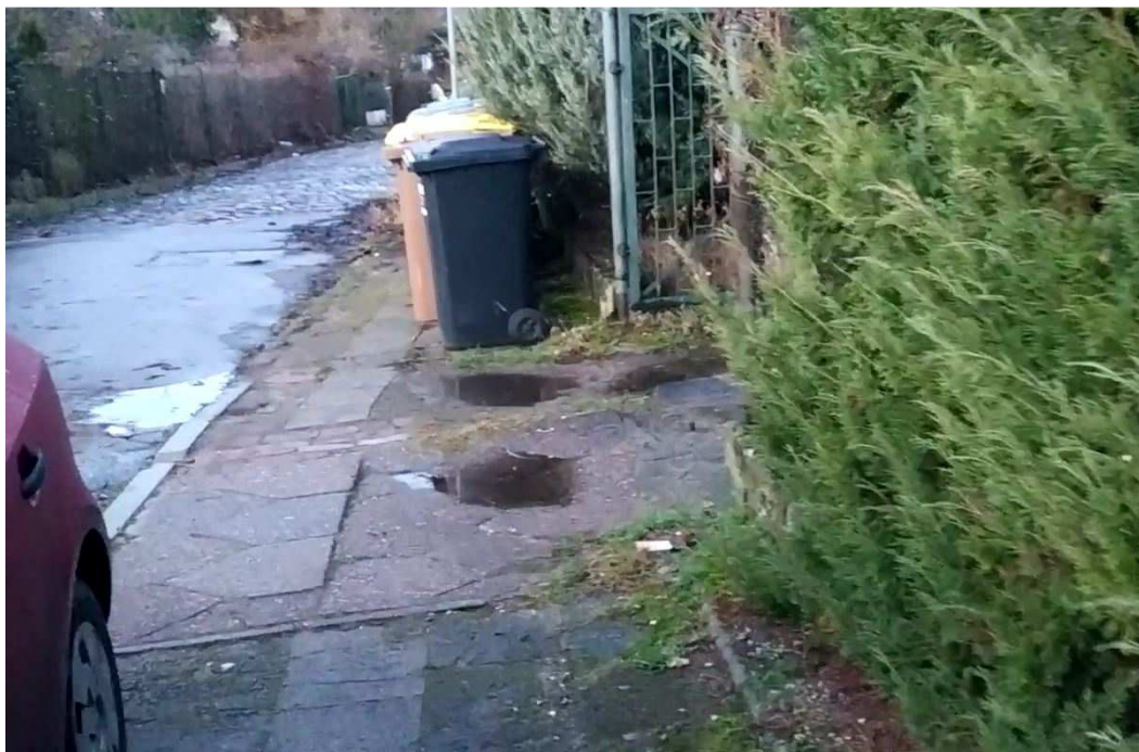
Początek chodnika – widok w kierunku ul. Skłodowskiej - Curie
