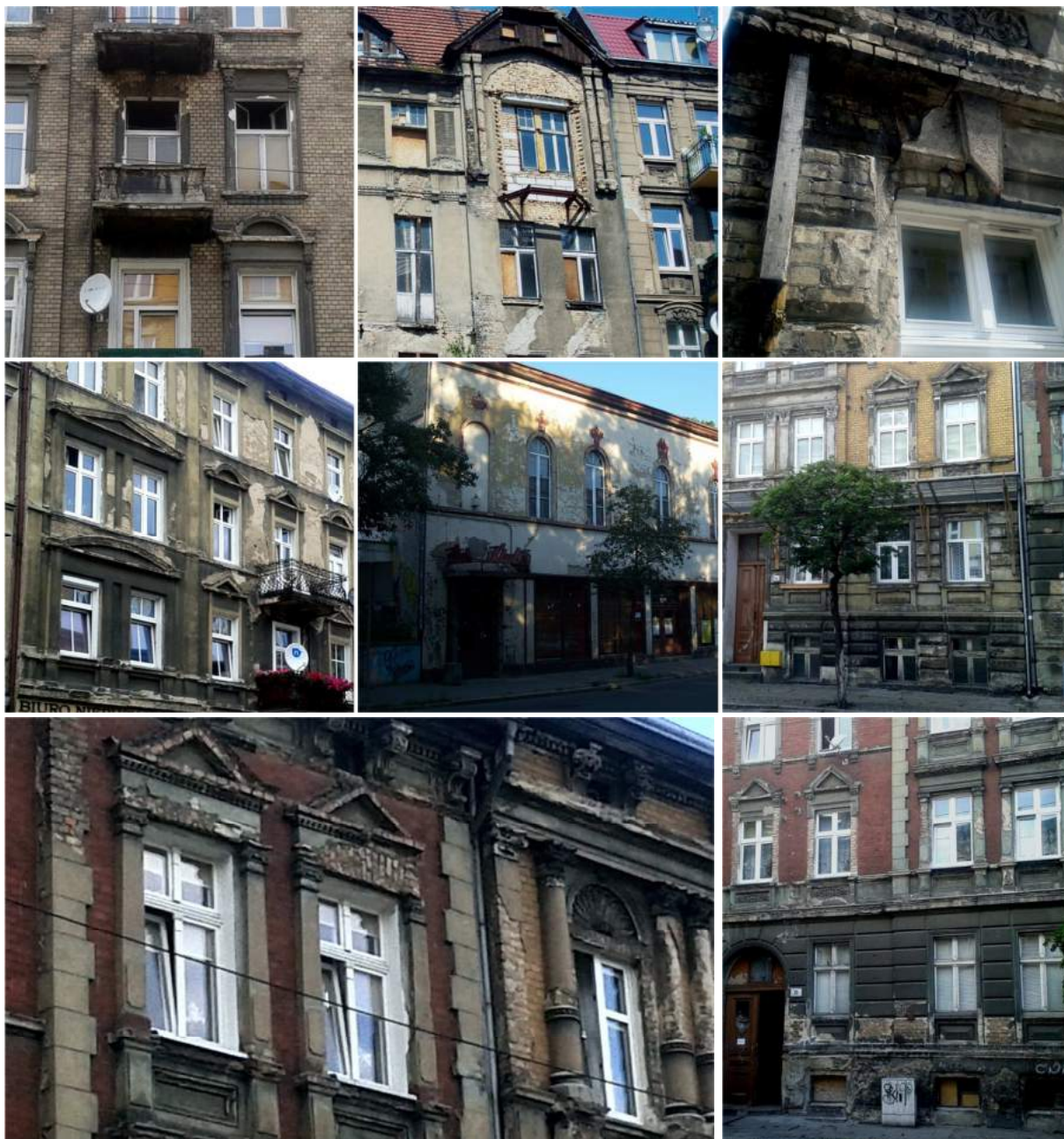
Ryc. 43. Faktyczny stan techniczny przykładowych budynków; prawdopodobnie konieczność remontu kapitalnego, lub interwencyjnego
