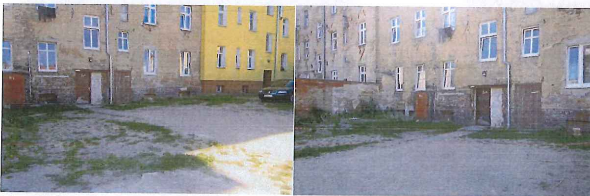
Fot. nr 13 Wejście do kamienicy ( działka o nr 1049) Fot. nr 14 Ceglany mur przeznaczony do rozbiórki
