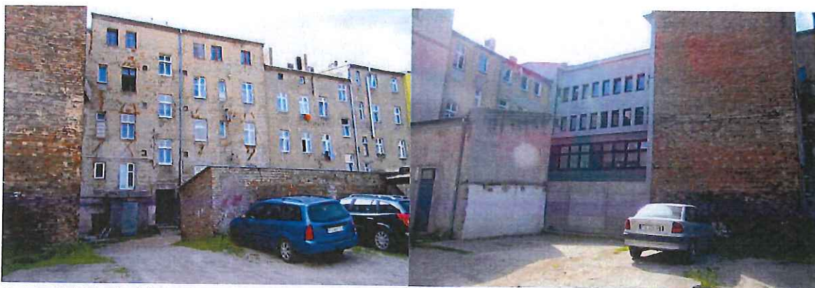
Fot. nr 11 Budynki przylegające do terenu opracowania; przejście na sąsiednie podwórk Fot. nr 12 Budynki przylegające do terenu opracowania
