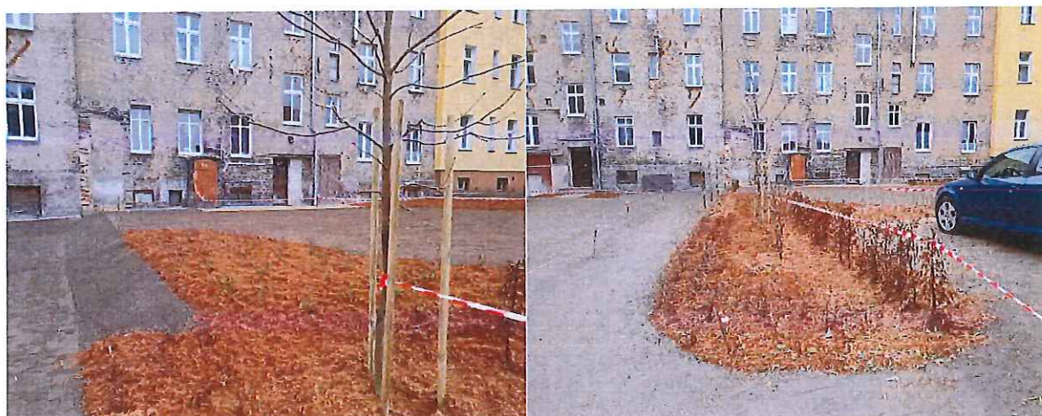
Fot. nr 25, 26 Podwórko ul. 30 Stycznia 25,26 w trakcie odbioru robót
