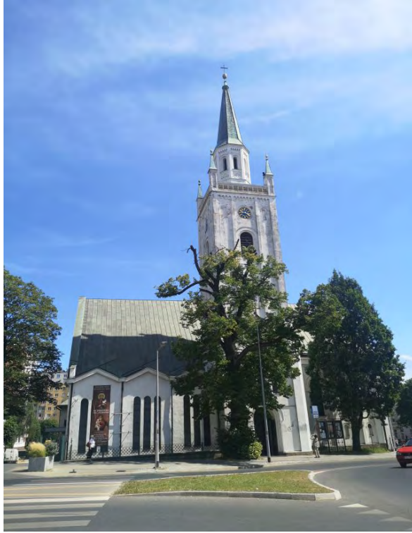
1. Widok od strony zachodniej
