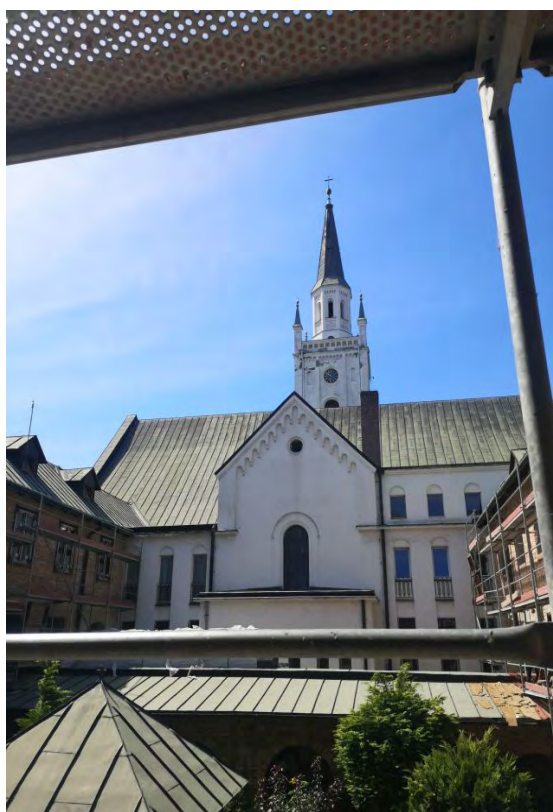
7. Widok na wschodnią elewację kościoła z II piętra budynku klasztornego
