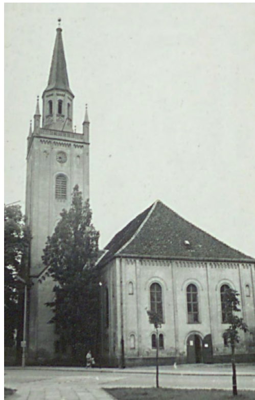
18. Widok na elewację płd – zach, z: Karta Ewidencyjna z 1965 r.
