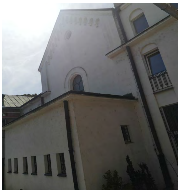
6. Elewacja wschodnia (fragment)
