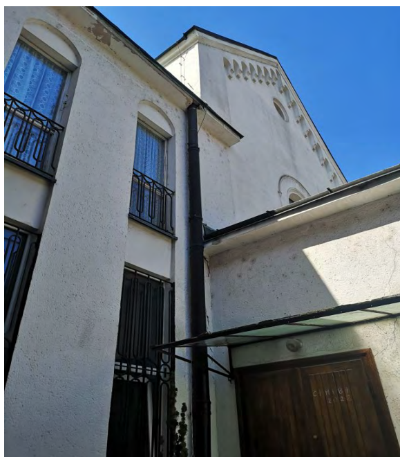
9. Fragment wschodniej elewacji kościoła
