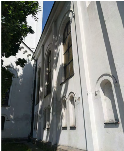
12. Fragment elewacji zachodniej od strony południowej
