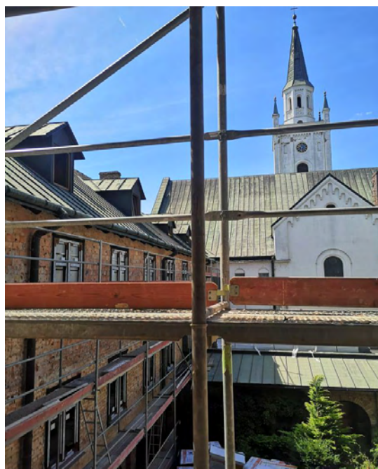
8. Widok na wschodnią elewację kościoła z II piętra budynku klasztornego
