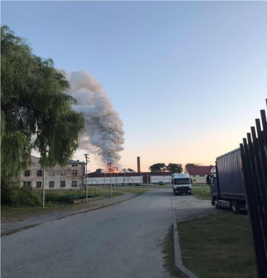
Pożar bardzo duży składowiska baterii w Zakładzie Utylizacji Odpadów Eneris Recypul w Stanowicach, gm. Bogdaniec. 08.07.2023
