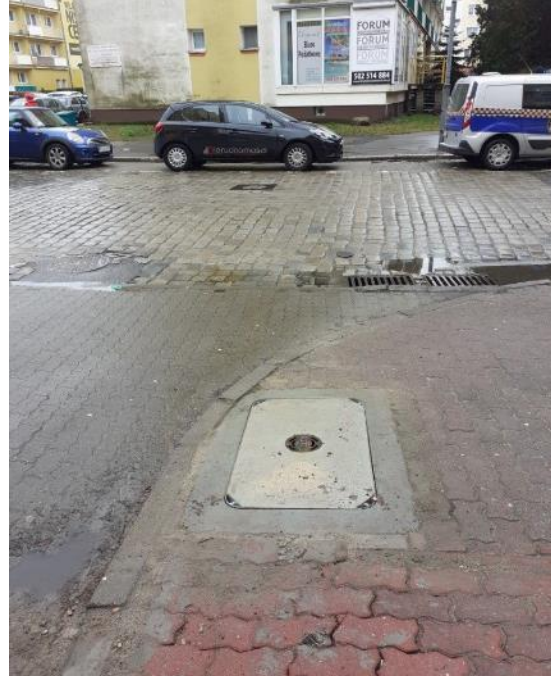
Rysunek 24 Naprawiona studzienka ul. Pocztowa - Stara.
